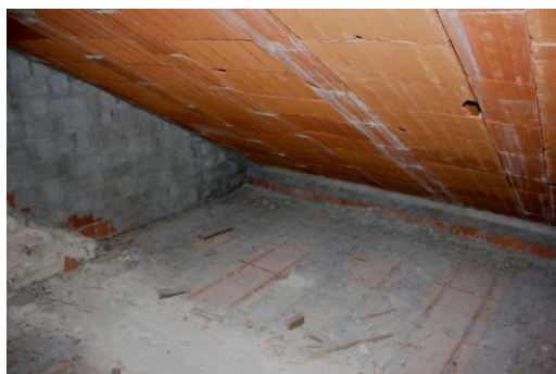
Fig. 4.1.14 Estradosso del terzo impalcato ed intradosso della copertura.
