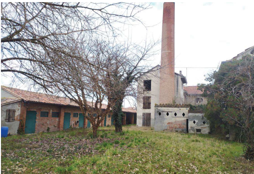
Figura 23: cono visuale 13 – Prospetto sud dei magazzini e dei bagni
