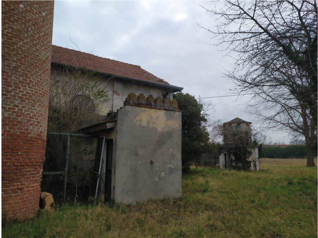
Figura 21: cono visuale 11 – Vista dei locali sanitari e della colombaia
