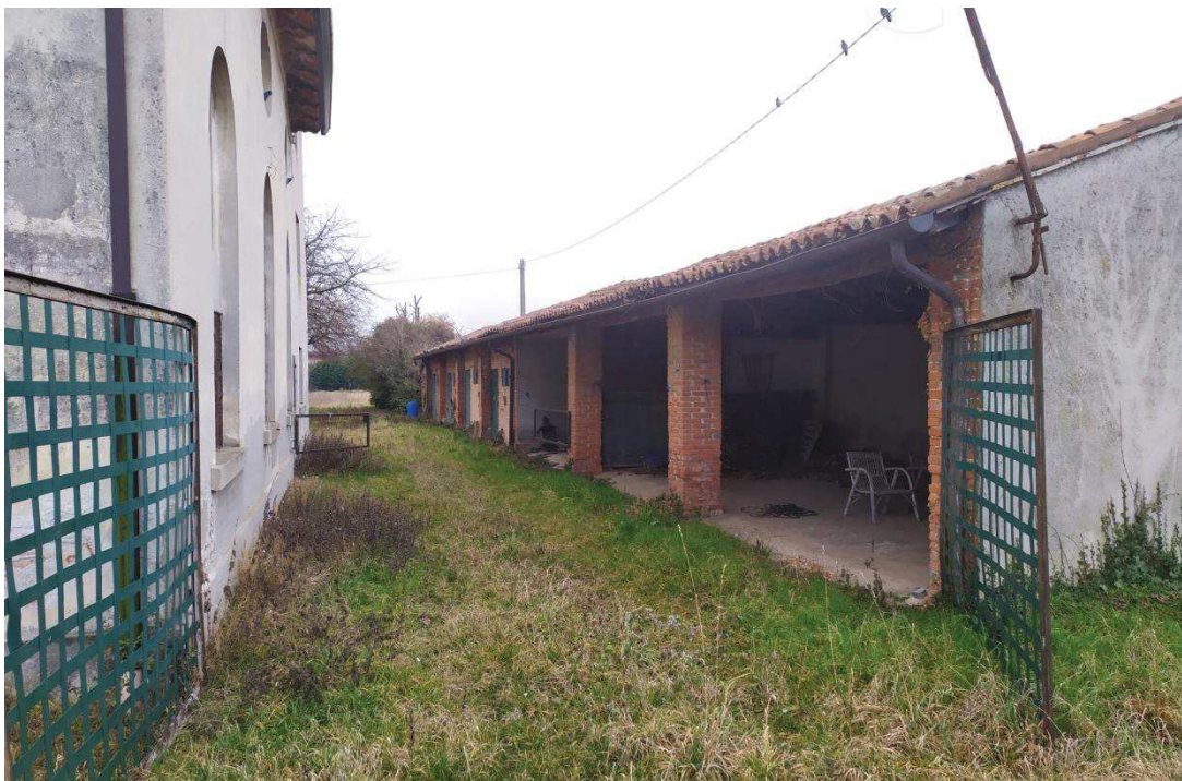
Figura 16: cono visuale 6 – Vista delle stalle
