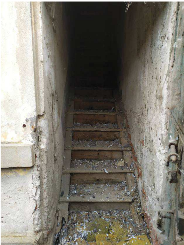
Figura 19: cono visuale 9 – Scale di accesso ai magazzini
