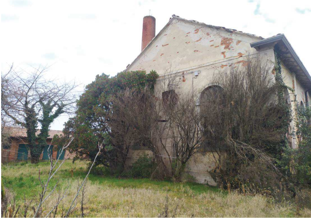
Figura 25: cono visuale 15 – Prospetto sud dell'opificio
