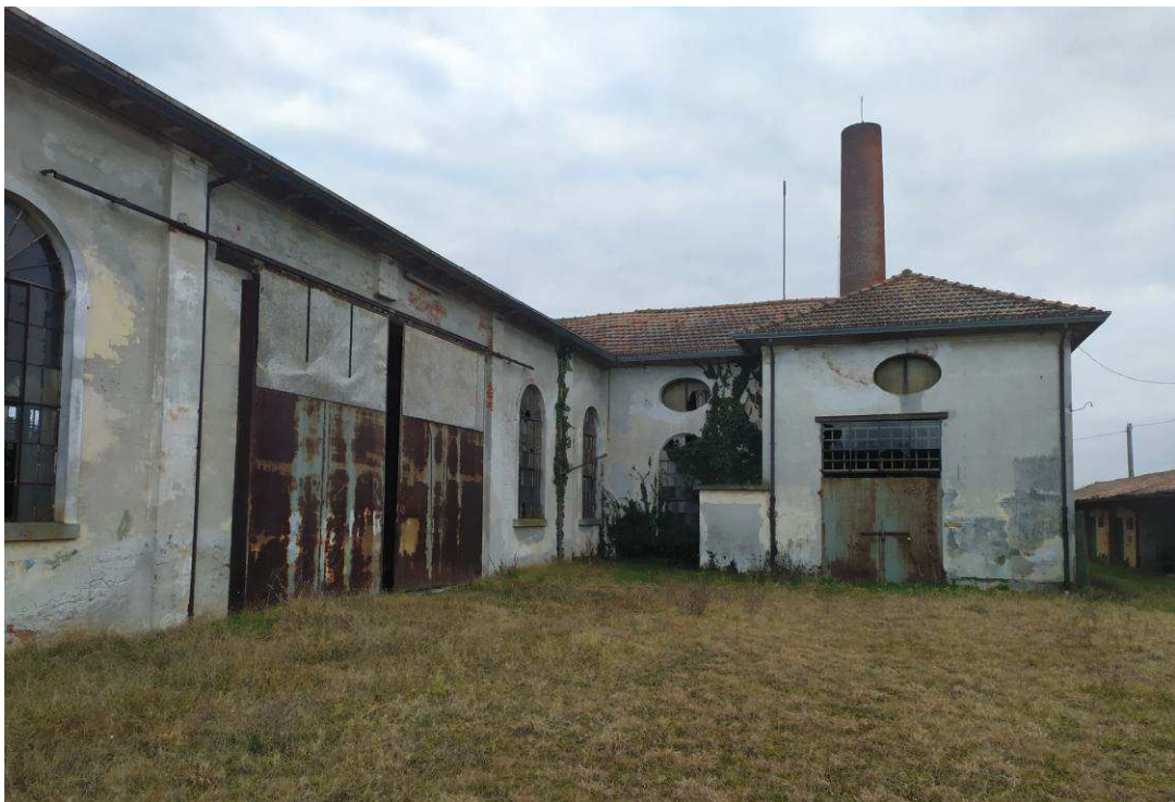
Figura 14: cono visuale 4 – Prospetto nord dei magazzini
