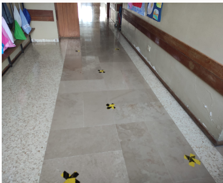
Fig. 2 il corridoio con i segni a terra
