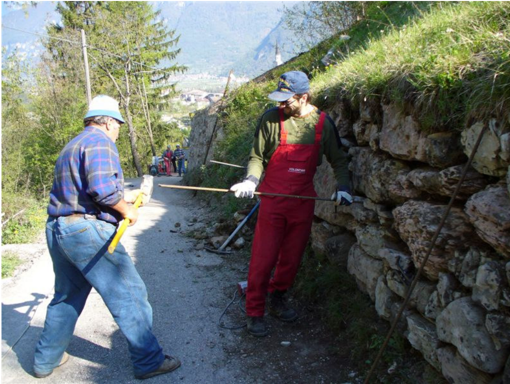
Foto n°18, prima fase di infissione per mezzo di mazza.
