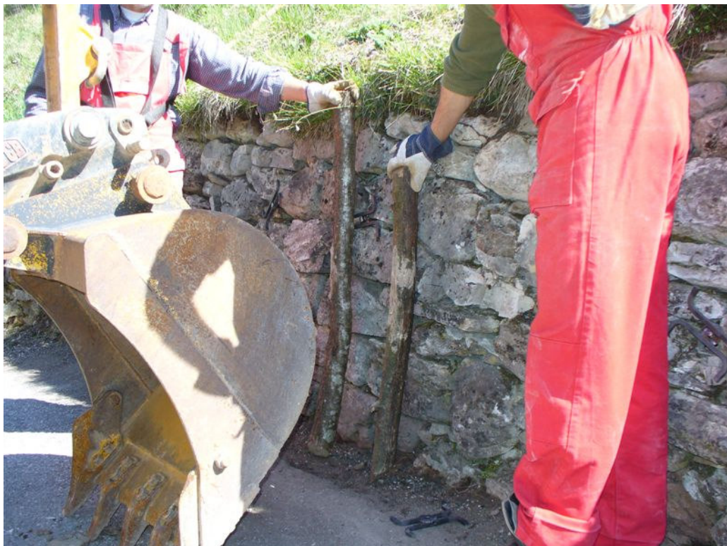
Foto n°21, riduzione dello spanciamento del muretto a secco.
