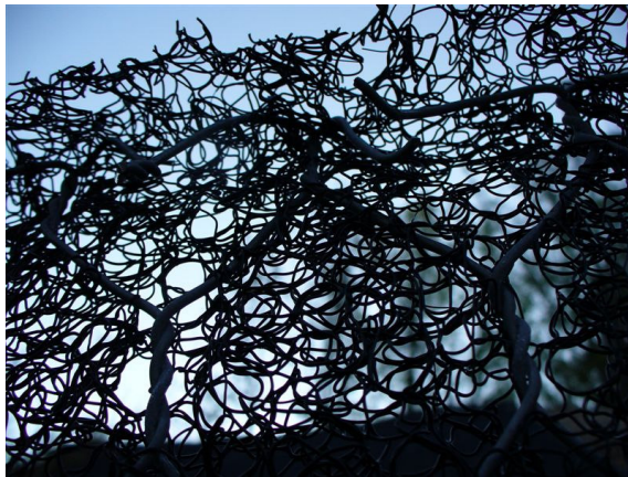
Foto n°16, rete metallica abbinata a geostuoia.
