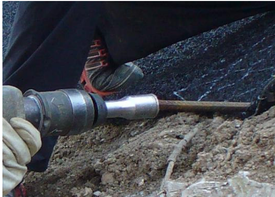
Foto n°12, dispositivo di infissione con estremità maschio/femmina.
