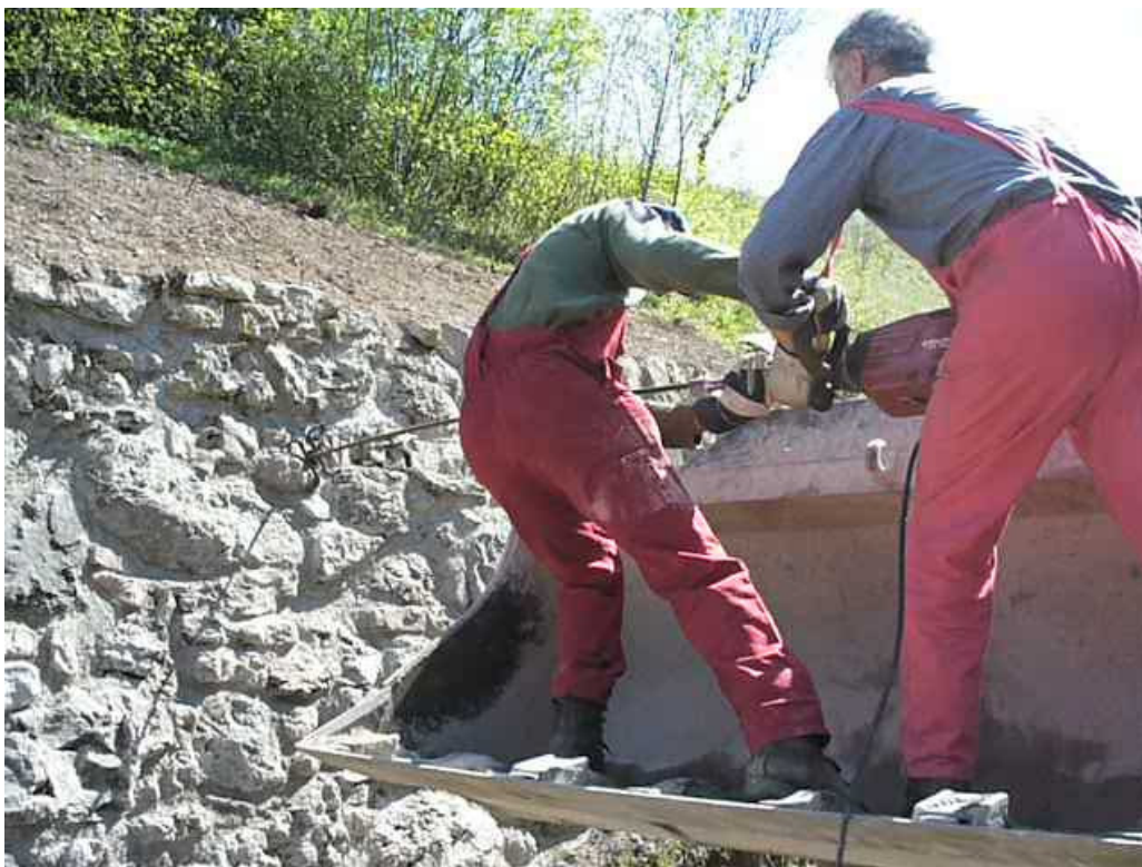
Foto n°23, Pala di una ruspa usata come piano di appoggio rialzato per l'infissione.
