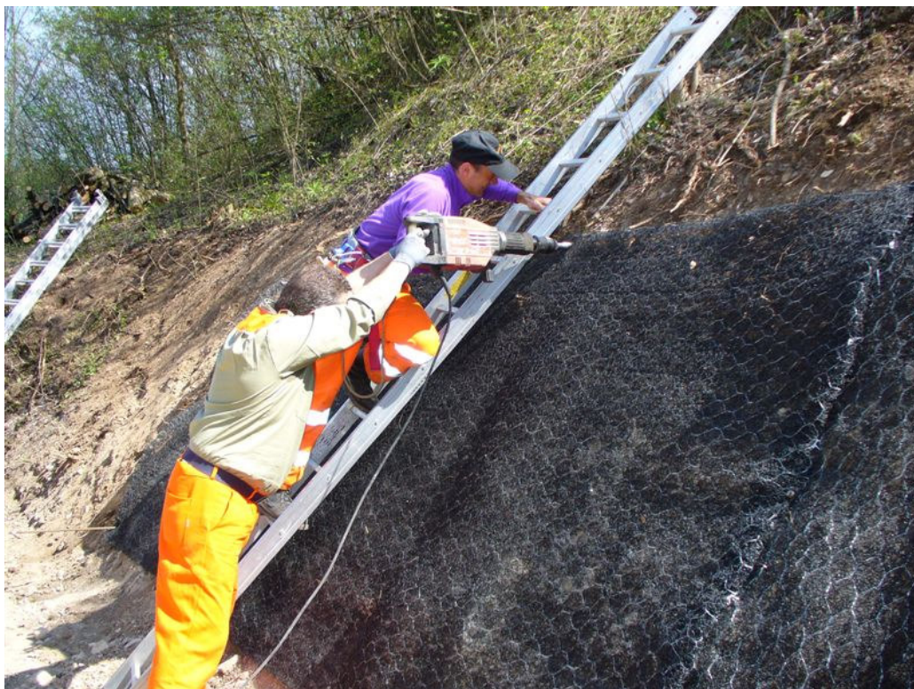
Foto n°24, infissione con l'aiuto di una scala in alluminio.
