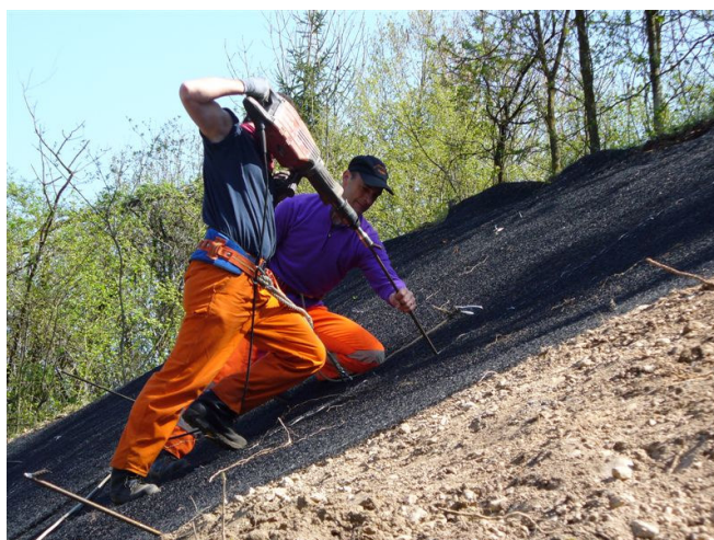
Foto n°27, infissione di barre sul pendio.
