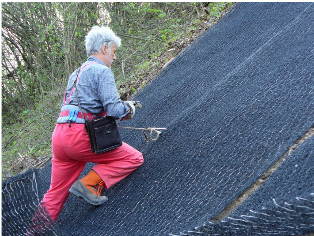
Foto n°25, legatura di due reti attigue.
