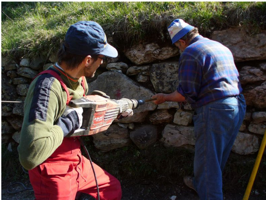
Foto n°19, fase di infissione per mezzo di martello demolitore.
