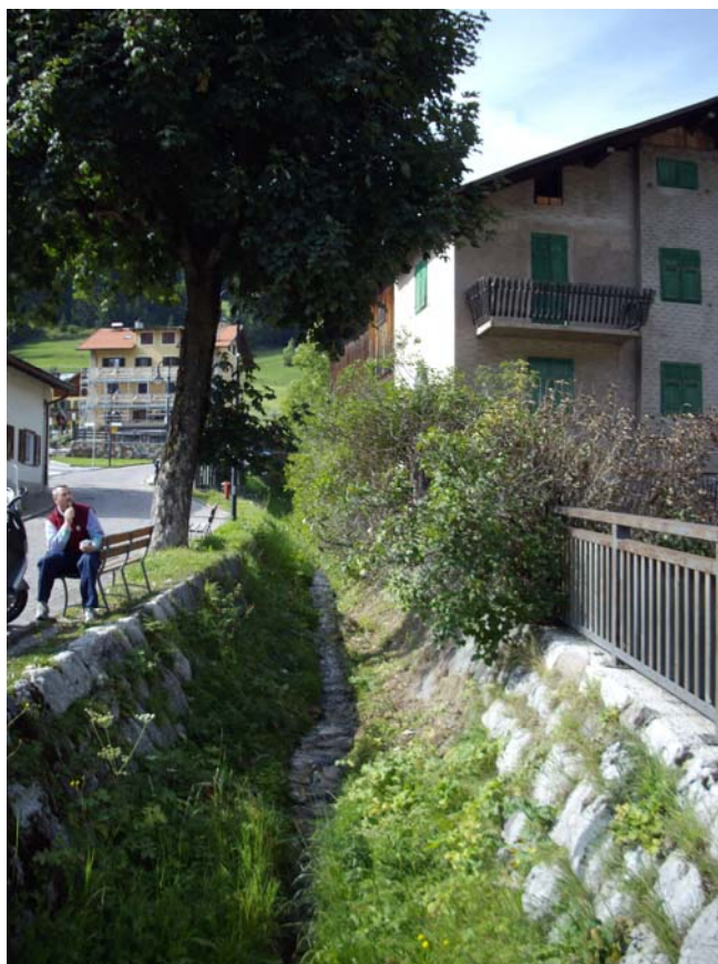
Figura 5.11 Canalizzazione della frazione di Soraga.
