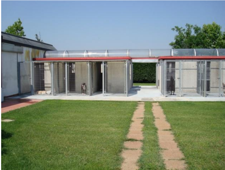
Foto n.3-1: Il canile di Selvazzano, cortile interno
