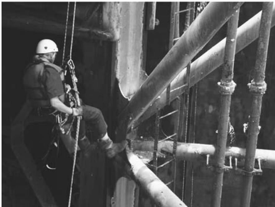
Fig.7.1.1 Imbragatura per accedere alle zone d'ispezione nelle installazioni offshore.
