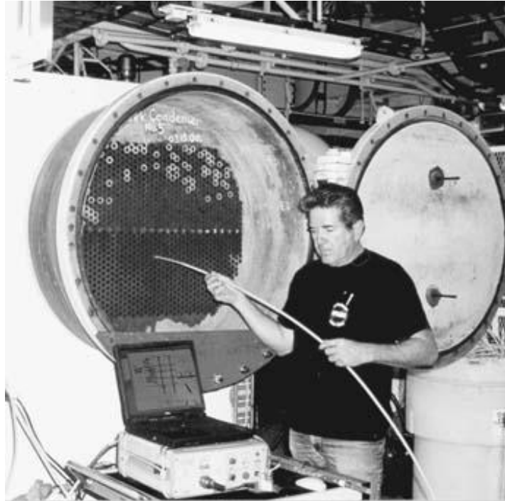
Fig.4.4.1. Controllo dei tubi di uno scambiatore di calore utilizzando un sistema a multifrequenza.
