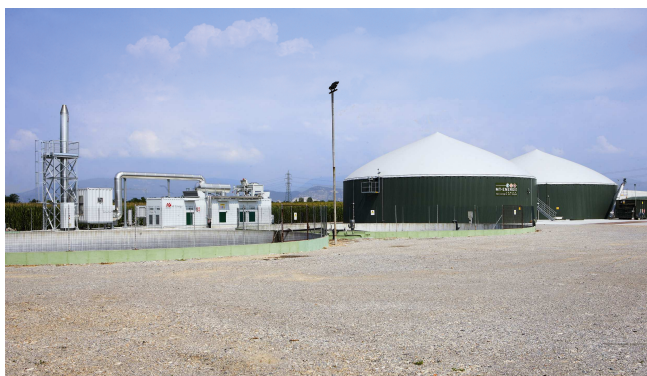
<Foto 6.3> Altra vista dell'impianto da 327 kWel dell'azienda FERRARIO
