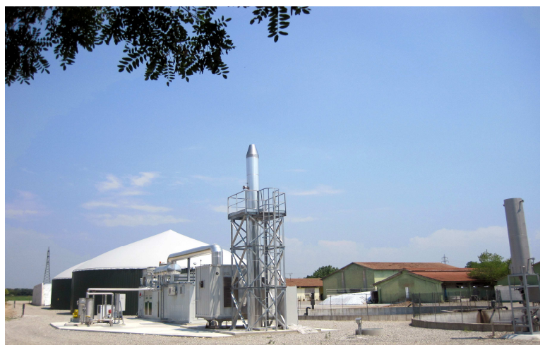
<Foto 1.17> In primo piano il camino collegato al termoreattore di trattamento fumi del cogeneratore dell'impianto F.lli FERRARIO
