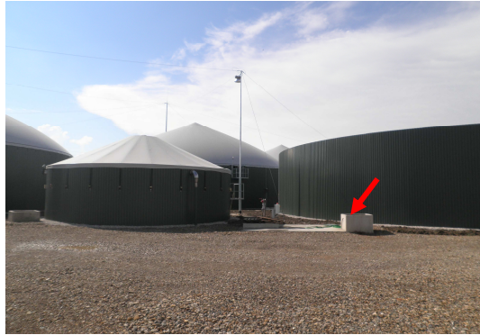
<Foto1.4> In primo piano la pre-vasca liquami circolare. La freccia indica il punto di scarico del carro-botte nella vasca interrata
