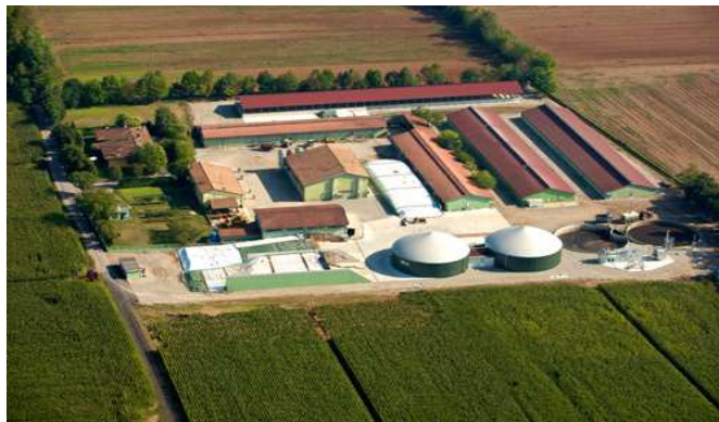
<Foto 6.2> Vista aerea complessiva dell'impianto da 327 kWel dell'Azienda Agricola FERRARIO
