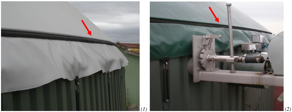
<Foto 2.1> Vedute diverse dell'anello a tenuta pneumatica perimetrale della membrana di copertura
