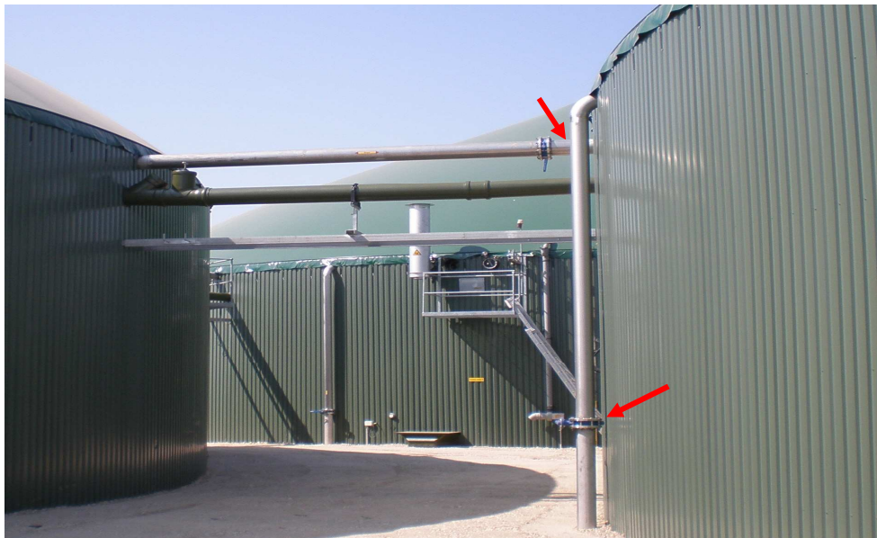
<Foto 2.2> Particolari degli accoppiamenti flangiati con valvola a farfalla
