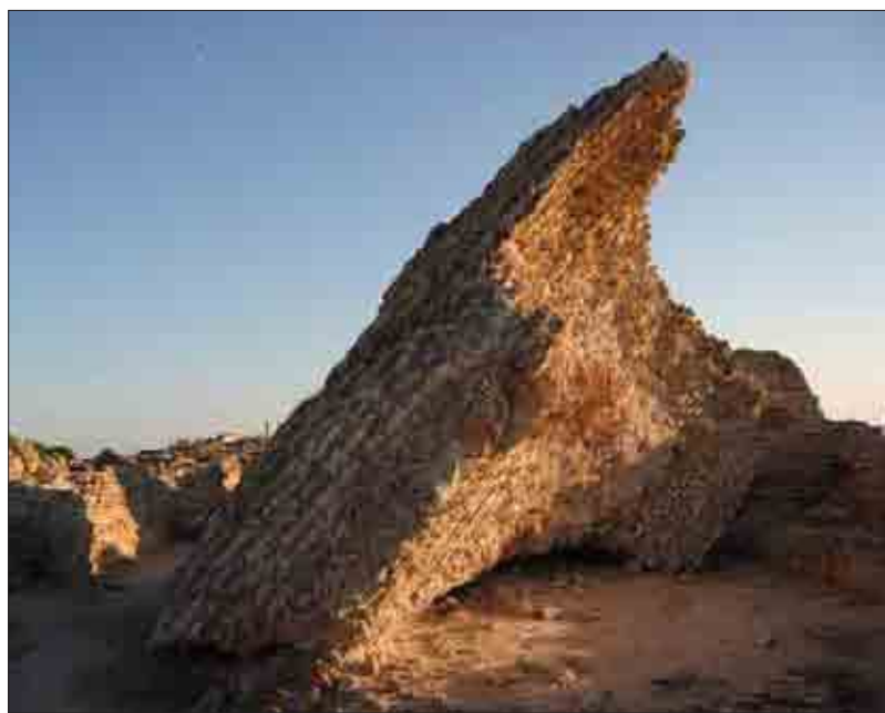
Fig. 26. Blocco in stato di crollo, originariamente pertinente alla volta a crociera dell'atrio 2 delle Terme a mare, vista da nord (foto L. Savio, ottobre 2010).
