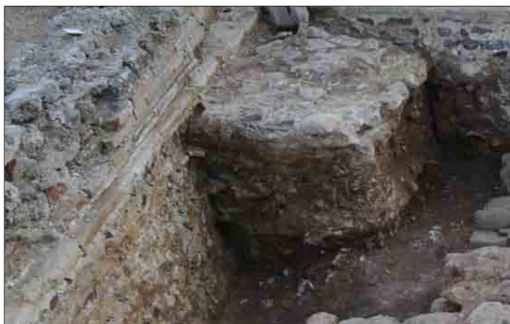
Fig. 65. Fondazione in opera cementizia nell'angolo sud-orientale della cella del Tempio romano, vista da nord (foto J. Bonetto, febbraio 2010).
