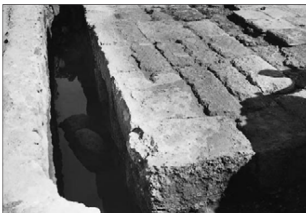
Fig. 37. Platea di fondazione del frigidarium B e del calidarium N delle Terme centrali, vista da nord (da PESCE 2000 2 , p. 151, fig. 36).
