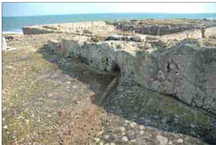
Fig. 48. Fistula plumbea nella porzione settentrionale dell'ambiente D della c.d. fullonica , vista da nord-est (foto S. Berto, aprile 2011).
