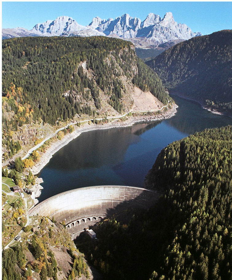
Fig. I.1 – Diga e Lago di Forte Buso [foto di Luca Pedrotti]
