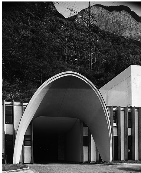
Fig. 5.5 – Portale esterno di accesso alla centrale di San Floriano [foto di Enrico Minasso]
