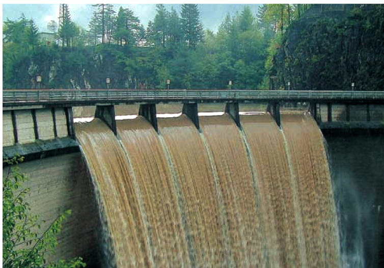
Fig. 5.8 – Scarico di superficie della Diga di Stramentizzo durante una piena [198]
