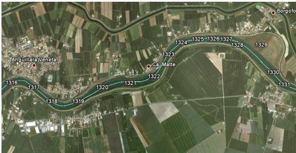
Fig.3.6 – Sezioni dell'alveo su Google Earth (AUTORITA' DI BACINO NAZIONALE DEL FIUME ADIGE).
