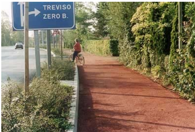
Fig. 1. Pista ciclabile realizzata in conglomerato bituminoso additivato con ossido di ferro.
