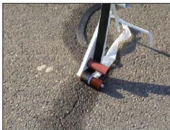
Posa in opera di nastro su fessura con primer
