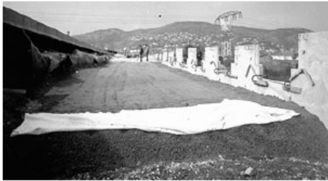
Fig.5: Sequenza di lavoro: posa del geotessile non tessuto, del primo strato di argilla e del primo strato di misto.
