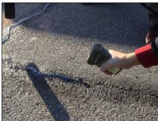
Misura di temperatura durante la stesa del nastro
