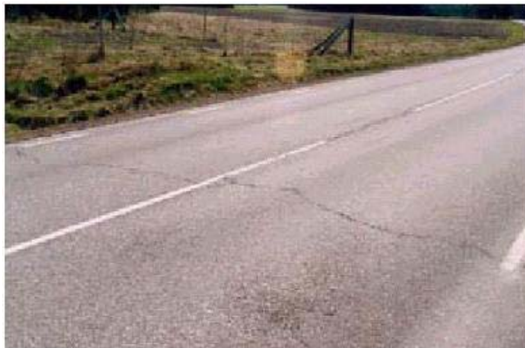
Fig. 2. Fessura trasversale dovuta alle basse temperature.
