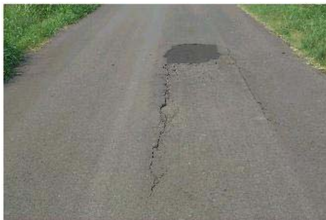
Fig. 7.42. Sezione di riferimento: nuovo cedimento dopo la riparazione.
