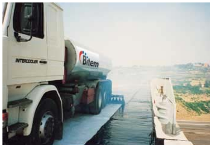
Fig. 3. Stesa a caldo del compound bituminoso sull’impalcato di un cavalcavia autostradale.
