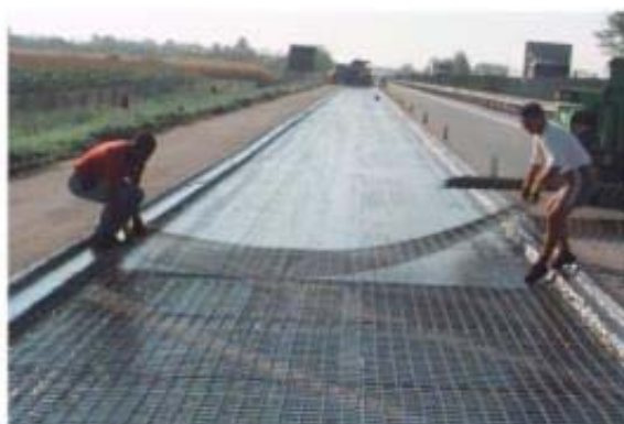
Fig. 7. 46. Posa in opera della rete elettrosaldata.
