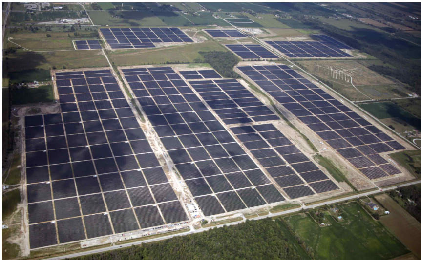
Figura 1.2.1: Centrale fotovoltaica di Sarnia, Ontario, Canada.
