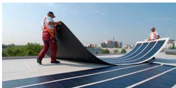
Figura 3.2.2: Moduli in silicio amorfo, si evidenzia flessibilità, dimensione facilità di messa in opera.
