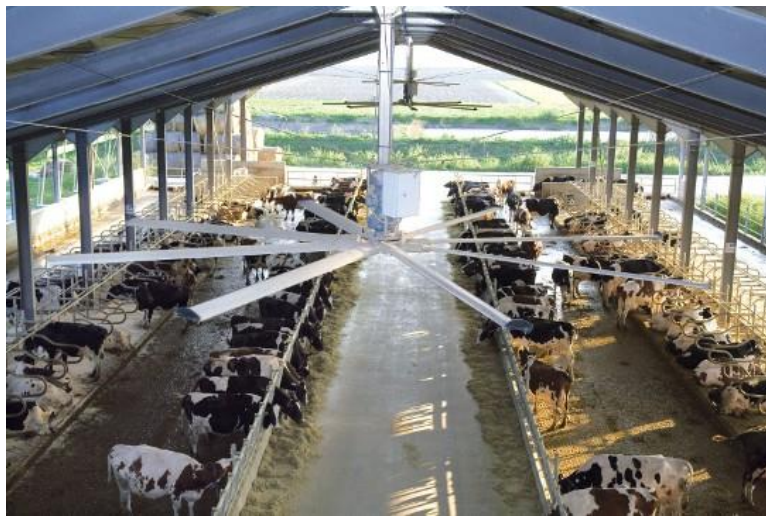
Fig. 12: Grande ventilatore ad asse verticale e pale orizzontali: è in grado di diminuire il tasso d'umidità della stalla e garantisce un maggior ricambio d'aria uniforme.
