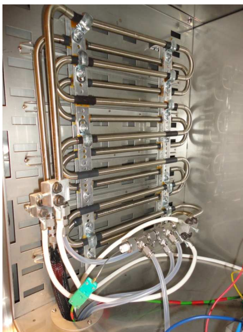
Figura 7.6 - Tubing lato aria.
