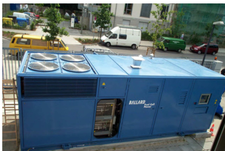
Figura 2.8 – Impianto PB2 da 250 kW alimentato a gas naturale a Berlino (Ballard).
