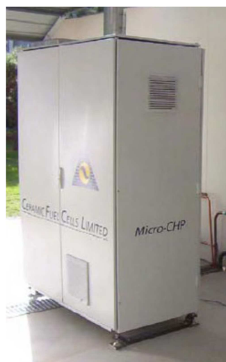
Figura 1.18b – Impianto per uso residenziale da 1 kW el e 1 kW t a Wellington (Ceramic FC).
