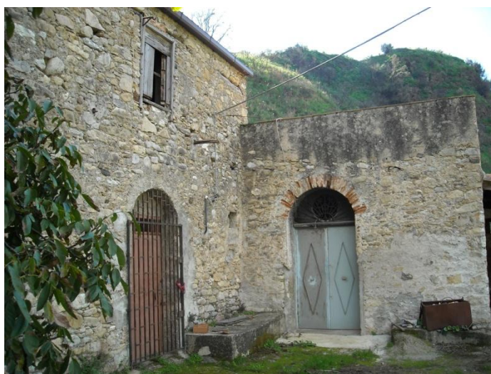
Figura 30 - Ingresso del "Molinello"
