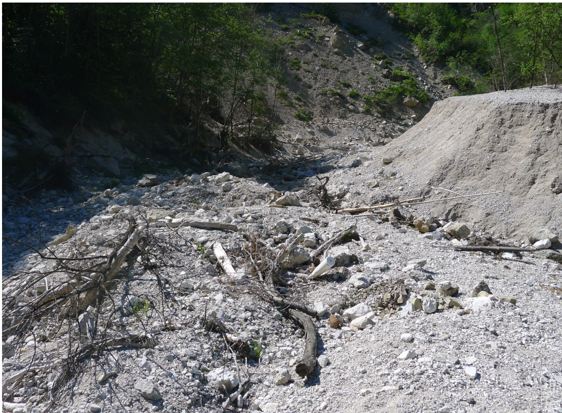
Fig. 4.25 Materiale detritico e legnoso presente nella piazza di deposito della briglia con finestre (briglia n°13).
