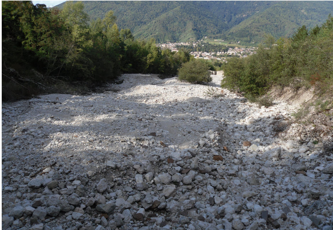
Fig. 5.18 Piazza di deposito della briglia filtrante (briglia n°16).
