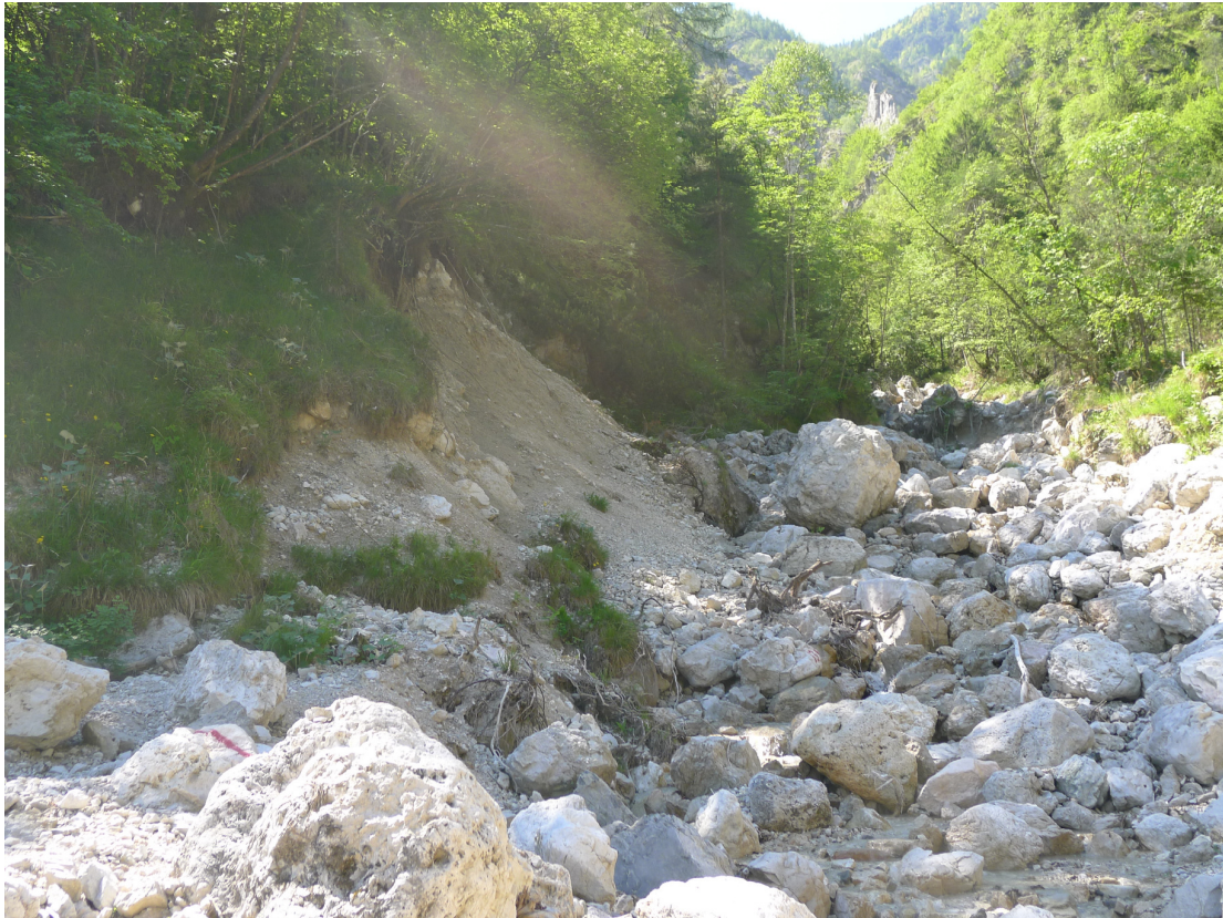
Fig. 4.30 Esempio di erosione presente lungo il secondo tratto del rio Rì.
