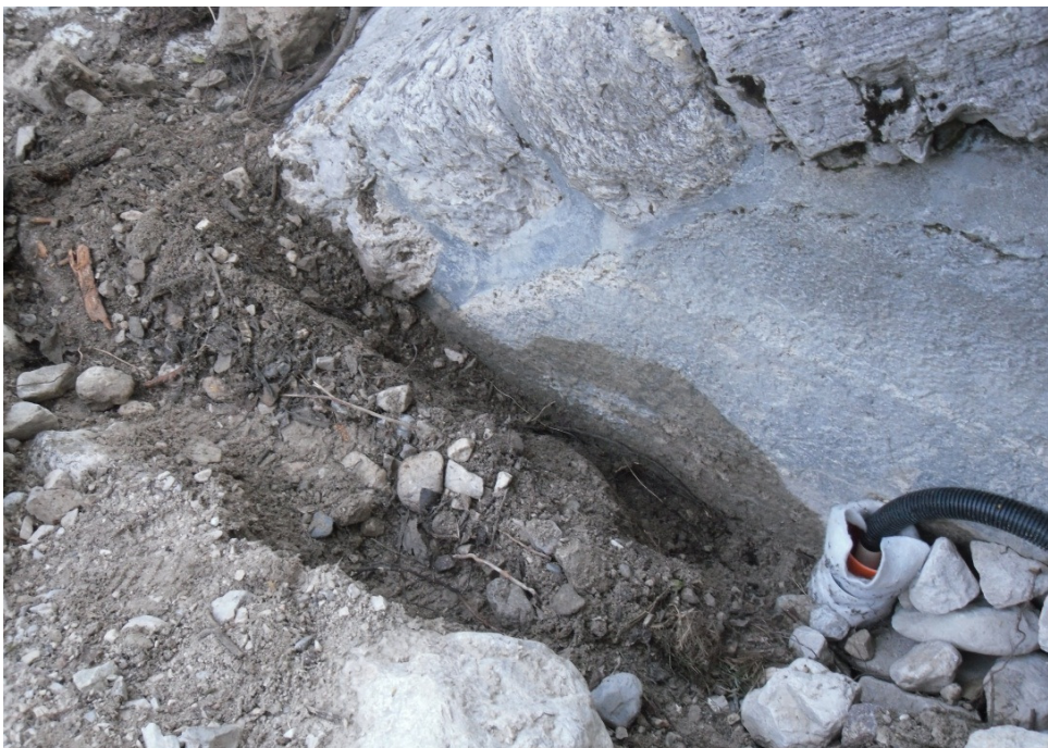
Fig. 7.11 Pozzetto contenente il piezometro e predisposizione dello scavo per il tubo di captazione.
