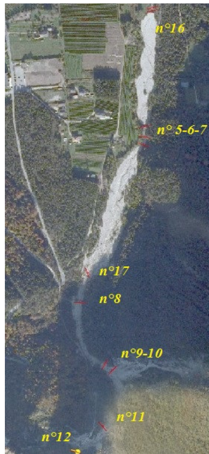
Fig. 5.10 Briglie presenti lungo il tratto con le due piazze di deposito sul rio Val Scura.
