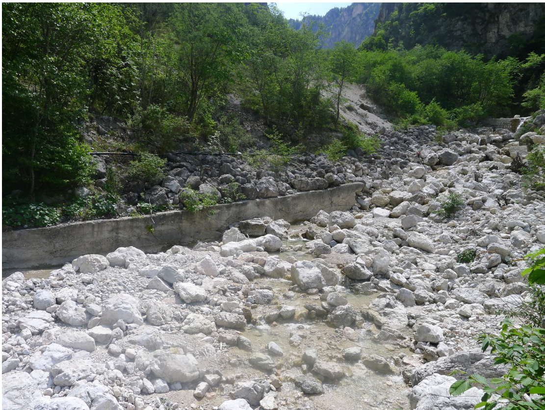
Fig. 5.37 Tratto d'alveo compreso fra le briglie n° 11 e n° 12.
