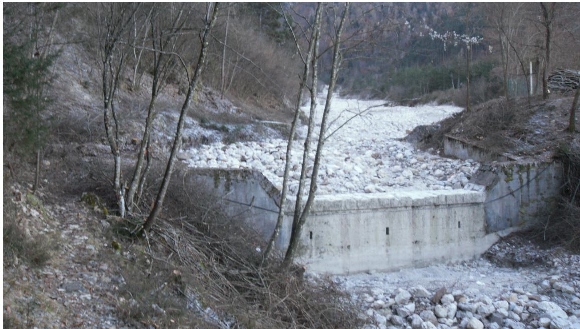
Fig. 7.23 Gaveta della briglia n°6 del rio Val Scura ove, a monte e in destra idrografica, si trova il piezometro. Come traspare dall'immagine, ci sono lunghi periodi in cui l'alveo è asciutto e la portata di magra defluisce completamente per via sottosuperficiale.
