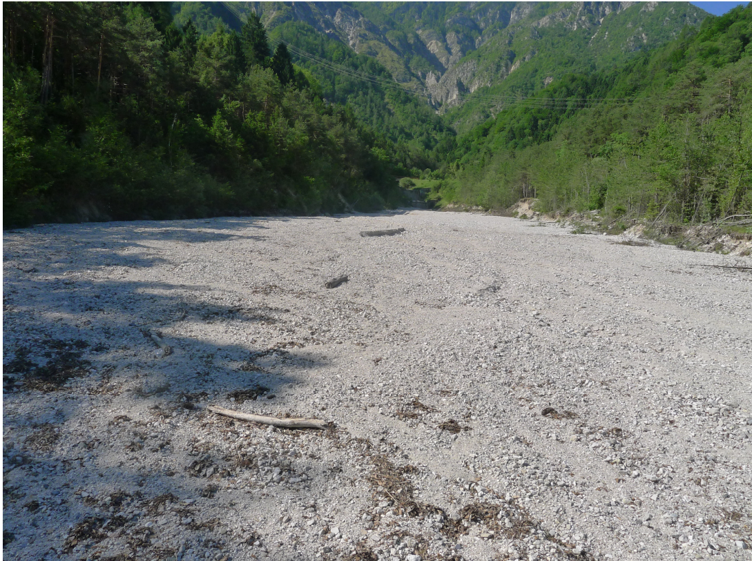
Fig. 4.22 Piazza di deposito della briglia filtrante (briglia n°6).
