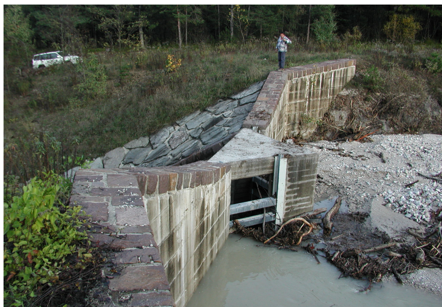
Fig. 5.9 Briglia filtrante sul Rio Val Scura in seguito all'evento del 2004 (fonte: Grisotto).
