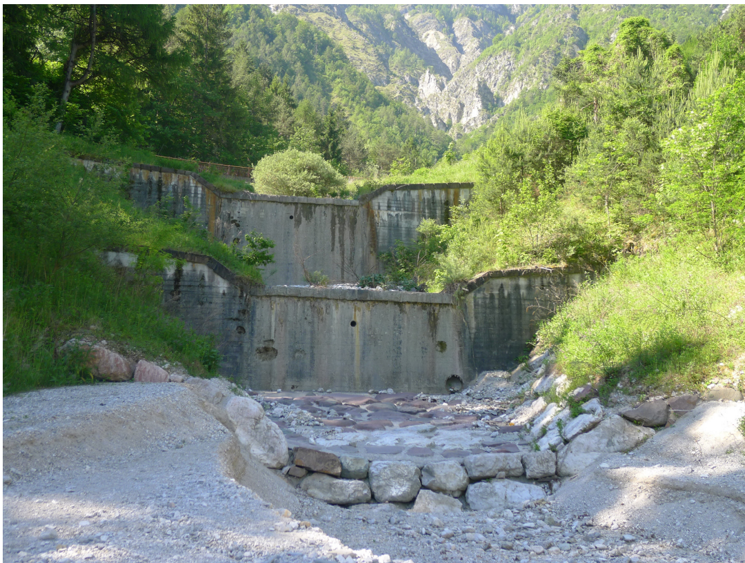
Fig. 4.15 Briglie (n° 7,8,9) in cemento armato posta a monte della filtrante.
