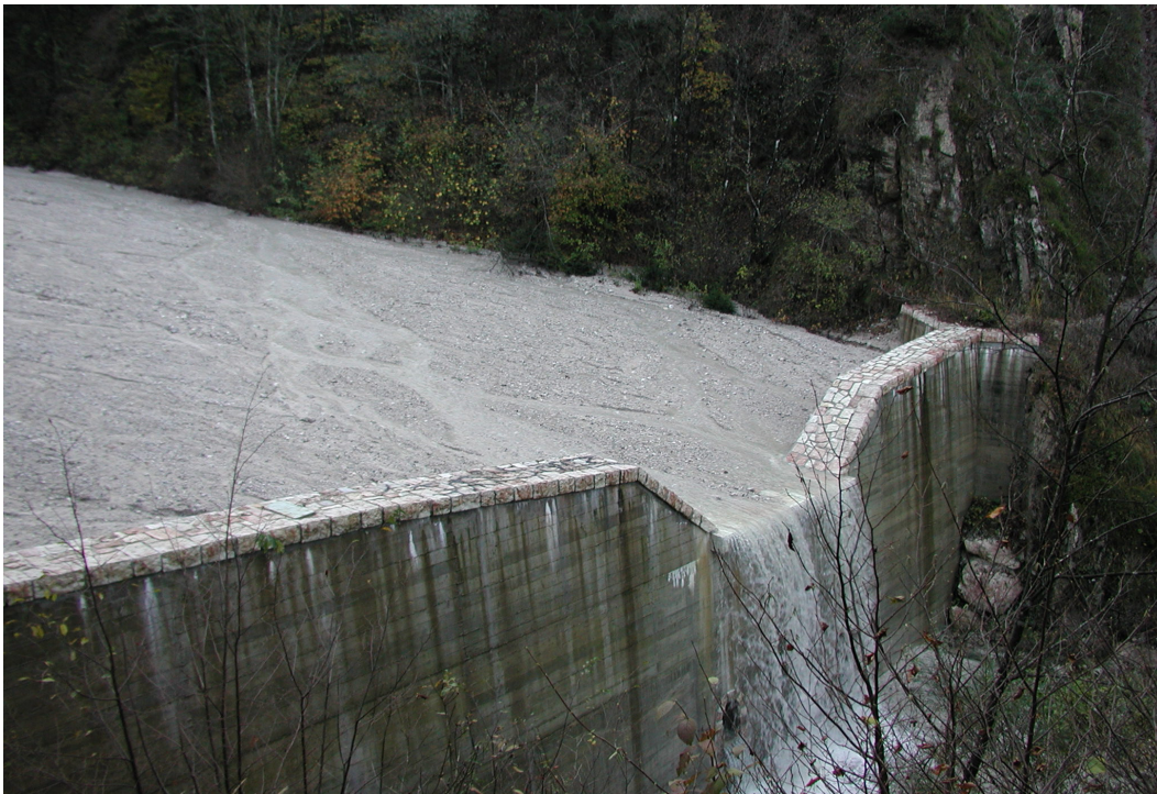
Fig. 4.17 Briglia in cemento armato n°13.
