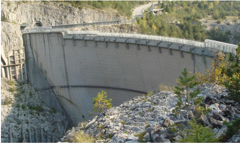
Foto 2 - Diga del Vajont
