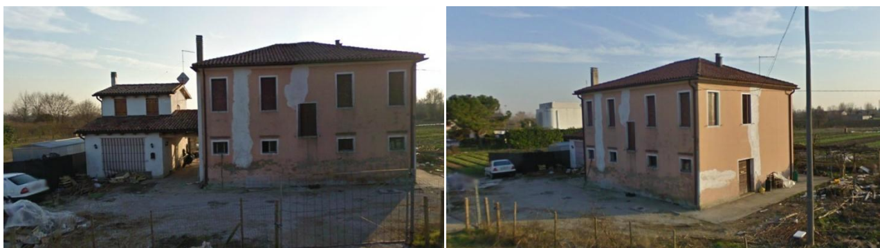
Fig. 36 - Stato di fatto dell'edificio.
