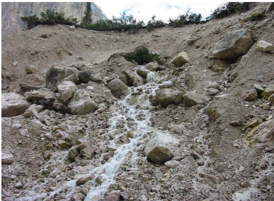
Fig. 4.46 – Sorgenti che sgorgano dalle sponde dell'alveo principale del Rudavoi.
