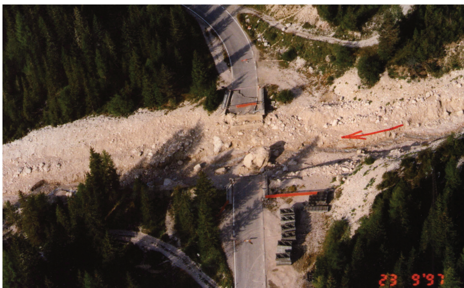
Fig.1.3 – Ponte sul Rudavoi distrutto in seguito all'evento del 4 settembre 1997 (foto: Fenti V., 1997).
