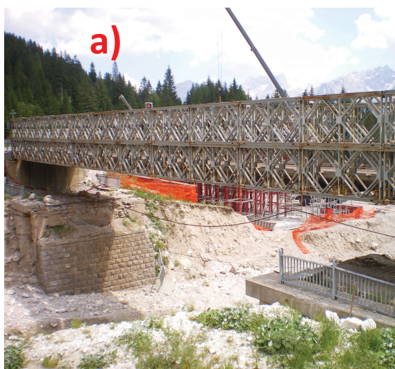
Fig. 1.4 – a) il ponte bailey provvisorio (2010); b) il nuovo ponte della SR 48 sul Rudavoi (2012).
