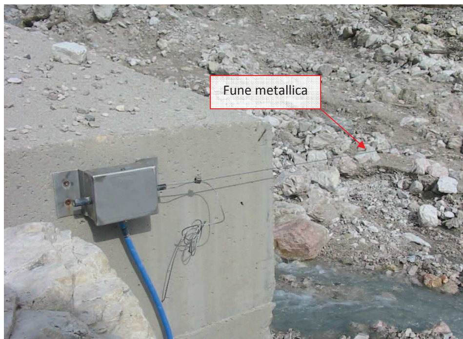
Fig. 5.10 - Sensore installato sulla ali della briglia; si nota la fune metallica sopra la gaveta.
