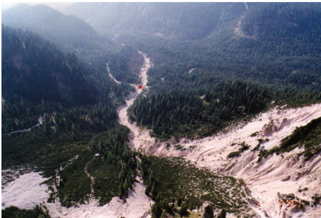
Fig. 5.2 - Panoramica da nord del bacino del Rudavoi e il ponte distrutto (punto rosso).
