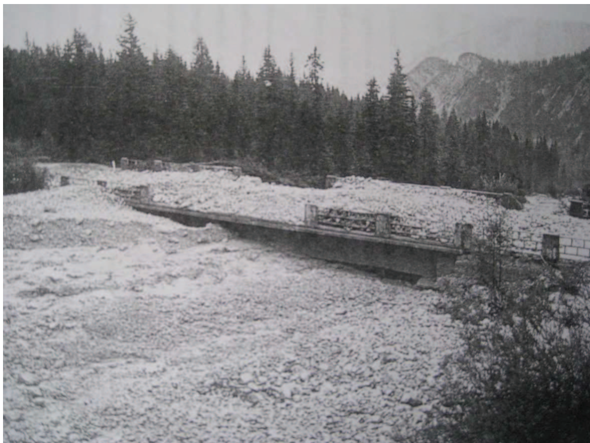
Fig. 5.1 - Ostruzione del ponte sul Rudavoi in seguito all'evento dell'agosto 1992 (Foto: R. Francese).
