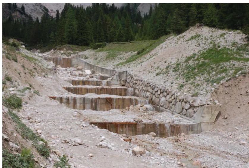
Fig. 4.8 - Tratto d'alveo sistemato con briglie a monte del ponte sulla SR 48.
