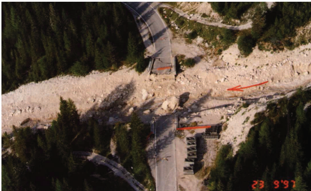
Fig. 5.2 - Vista del ponte distrutto sul Rudavoi dopo evento del settembre 1997 (Foto: V. Fenti).
