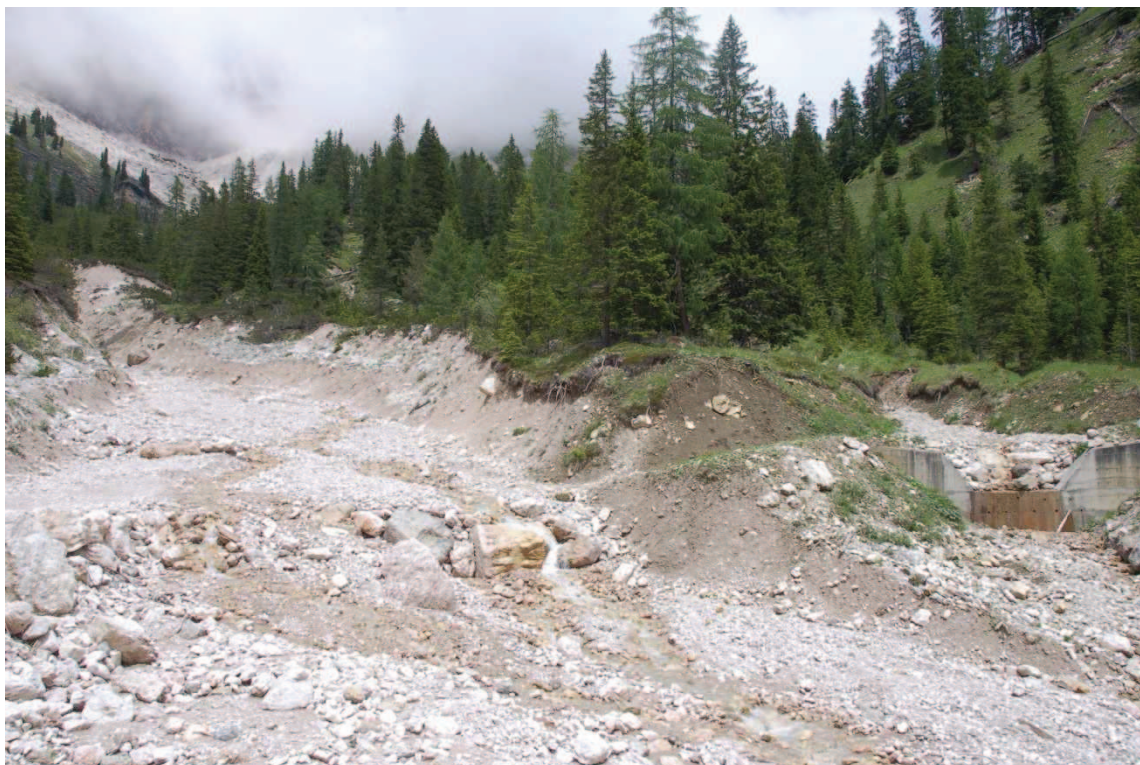
Fig. 4.9 – Tratto a monte delle briglie e presso la confluenza in sponda sinistra.
