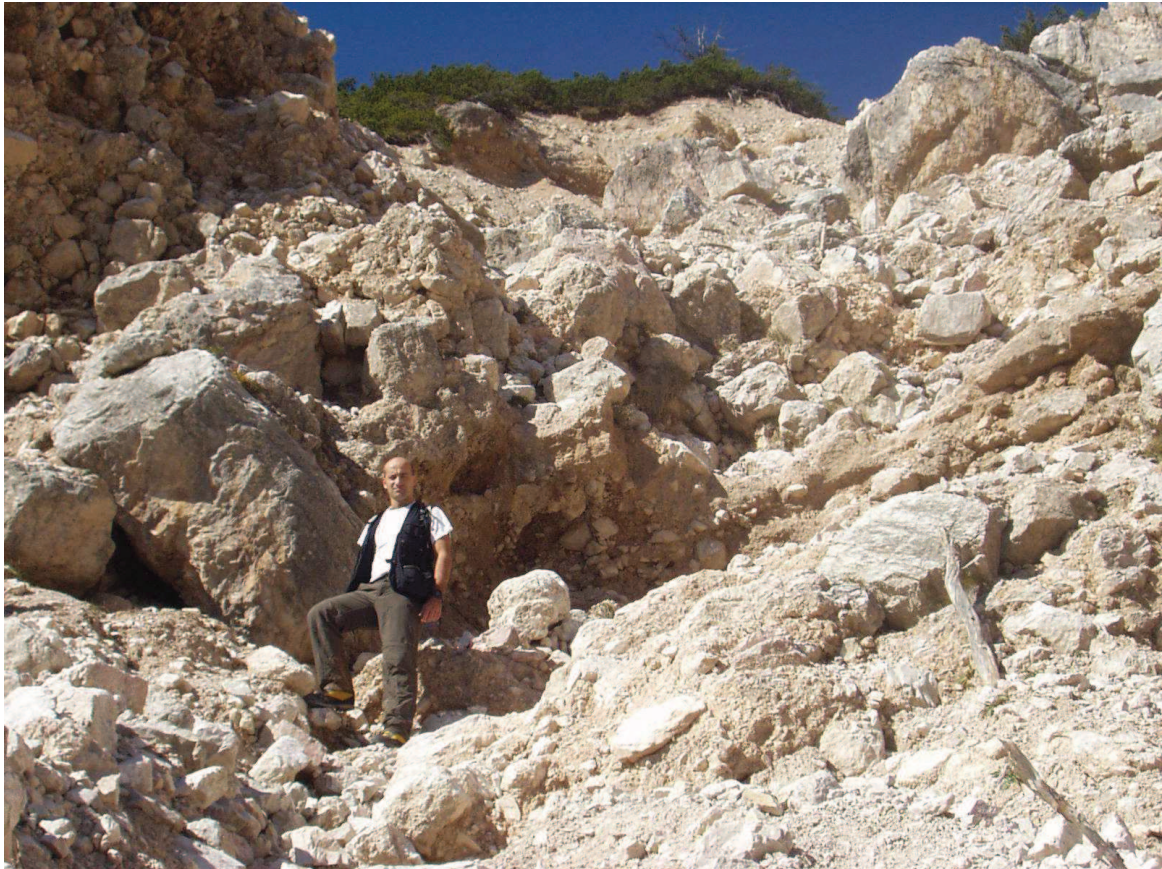
Fig. 4.31 - Erosione in destra idrografica: detriti ghiaiosi e massi instabili (foto: Gregoretti C., 2007).
