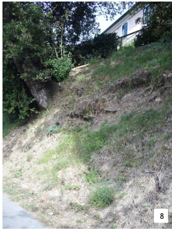
Foto. 7 e 8: cedimento per scivolamento della zolla intera su un piano inclinato (foto L. Sani).
