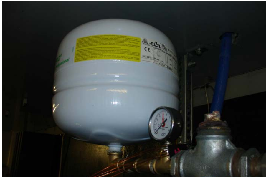
Figura 19 Vaso d'espansione Elbi D-CE 11
