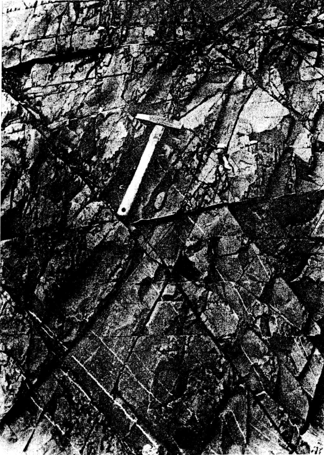
fig. 6 - Particolare delle fratturazioni che interessano le marne tufacee della Formazione di Wengen (La Valle). Ru delle Roe
