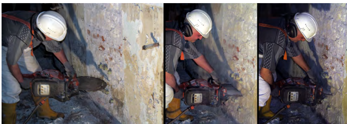
Figura 1.16: Taglio con mototroncatrice a disco diamantato eccentrico
