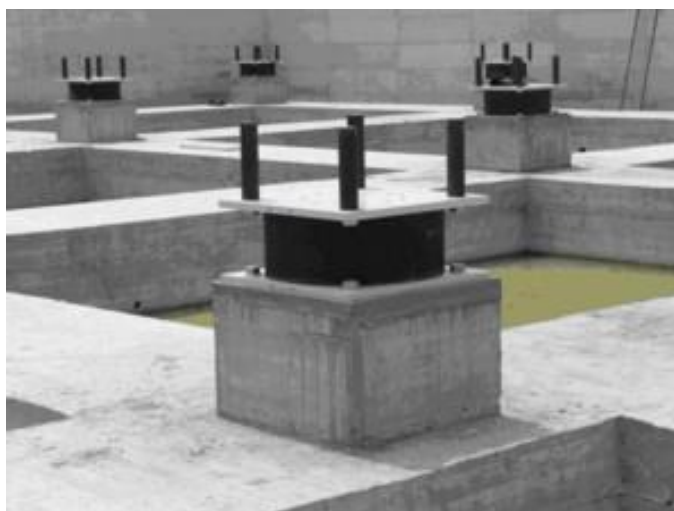
Figura 3.2: Esempio di isolatore elastomerico
