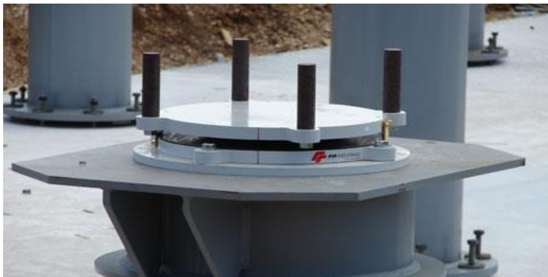
Figura 3.8: Isolatore a scorrimento
