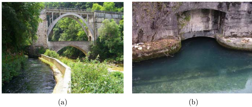
Figura 1.8: Opera di presa a Caltrano (a) e Botte a sifone dopo lo scarico della centrale di Calvene (b) [2]
