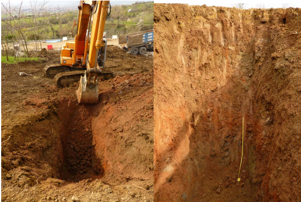
Fig.13: a) Fase di rimozione del terreno con un ausilio di macchina escavatrice (a sinistra); b) Collocazione della cordella metrica lungo la parete della trincea (a destra)
