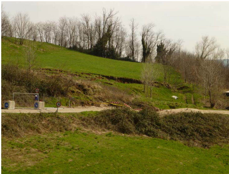
Fig.11: Pendice meridionale del Monte Grumo a monte della strada comunale
