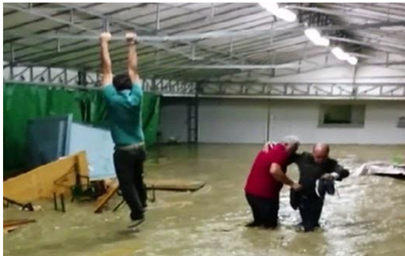
Figura 8: il capannone della Pro Loco travolto dal torrente. (Fonte: La Tribuna di Treviso)
