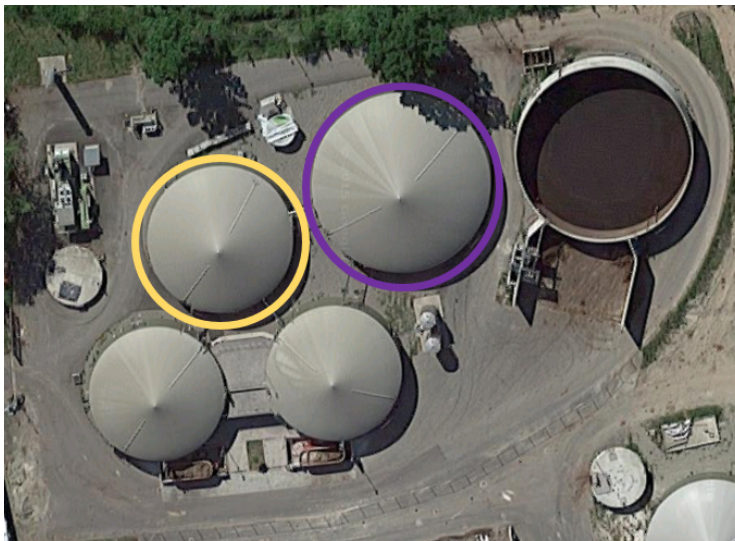
Figura 4.10: post-reattore e vasca di stoccaggio coperta
