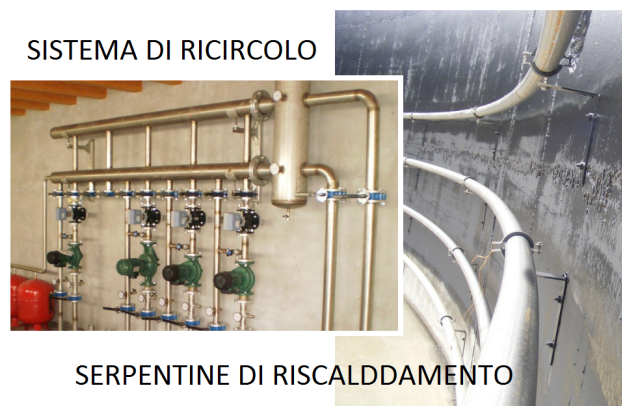
Figura 4.9: Sistema di riscaldamento e di circolazione
