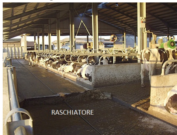
Figura 4.3: Sistema di raschiatura
