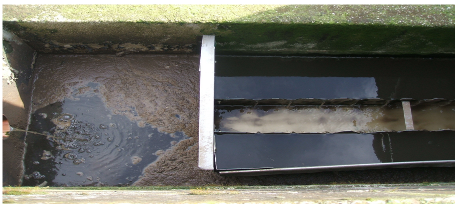
Fig. 3.4: Stramazzo del sedimentatore a pacchi lamellari.
