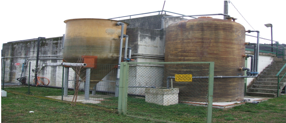
Fig. 3.7: Ispessitori per il fango di supero.
