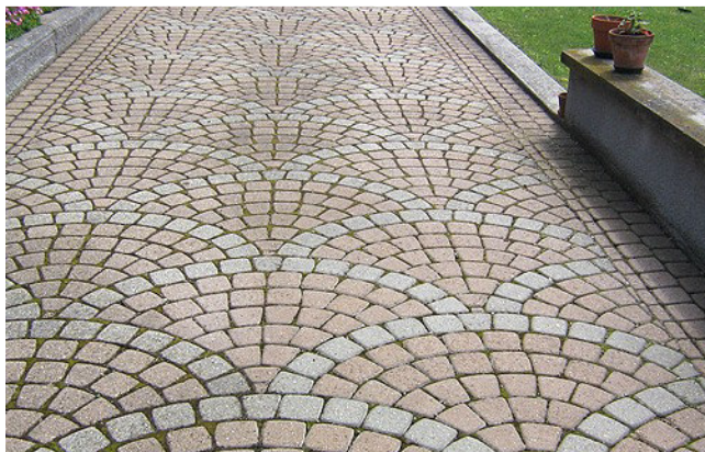
Figura 2.12 - Percorso realizzato in masselli quadrati di calcestruzzo autobloccanti.
