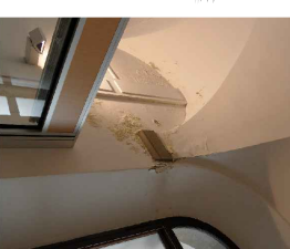
C.1 Alterazione cromatica, distacco, rigonfiamento
