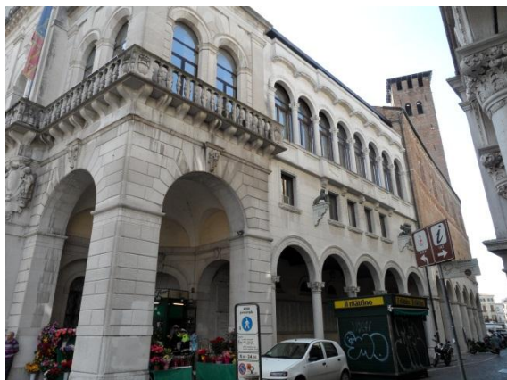
Fig. 3.1-06: Prospetto nord, su via Oberdan.
