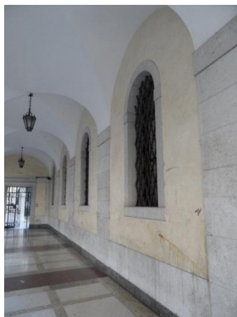
Fig. 3.1-11: Portico su via del Municipio.
