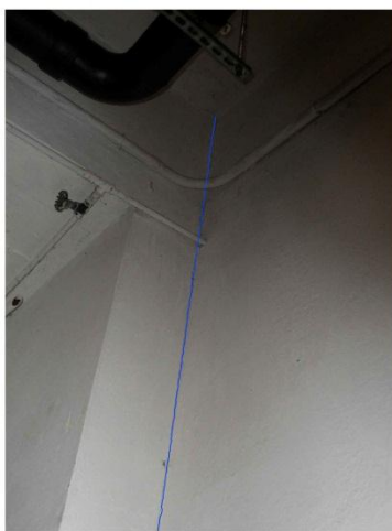
Fig. 6.4.1-03: Interrato: lesione fra pareti ortogonali, rappresentata in 3D ed evidenziata nella foto.
