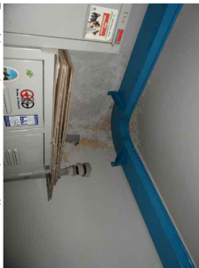
B.3 Alterazione cromatica, distacco, rigonfiamento
