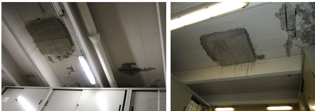
Fig. 6.4.3-04,05: Interrato: aperture sul solaio tamponate.
