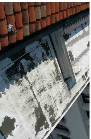
1. Solaio di copertura delle terrazze. Foto scattata dalla torre campanaria.
