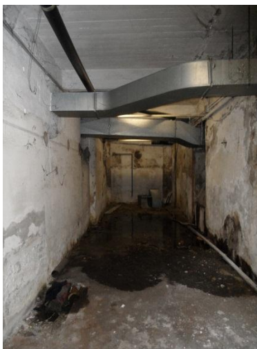
Fig. 3.2-05: Interrato: zona dismessa.
