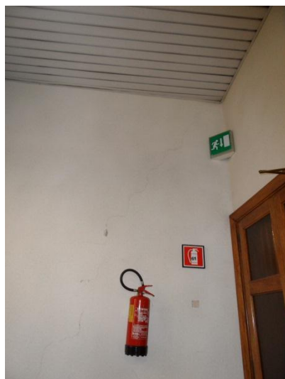
Fig. 7-11: 2P: estintore portatile.
