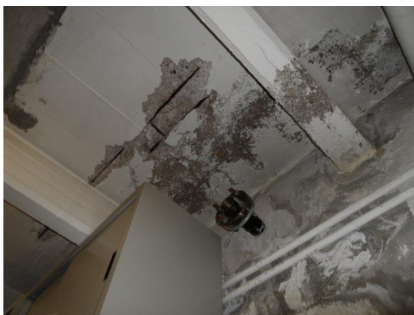
Fig. 6.2.3-01: Interrato: soffitto e travi in c.a..
