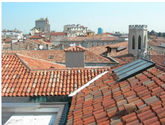
Fig. 3.1-04: Copertura, ali nord ed est.
