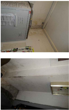
A.1 Alterazione cromatica, distacco
