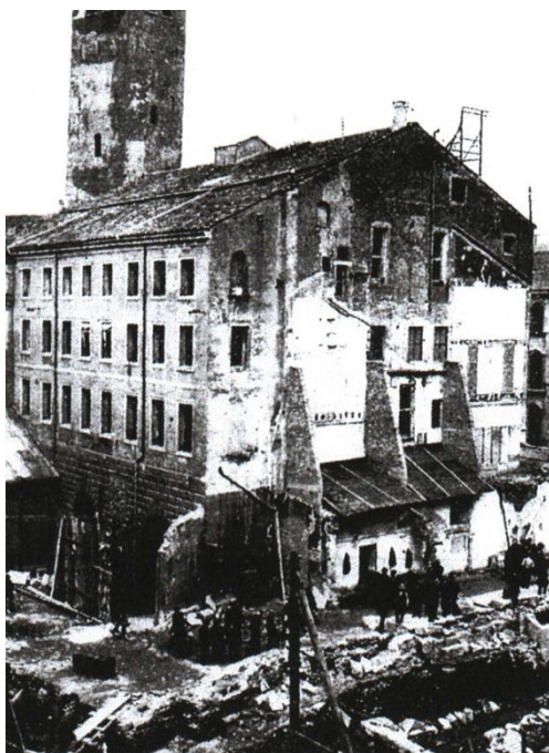
Fig. 2.2-15: Facciata est di Palazzo degli Anziani.
