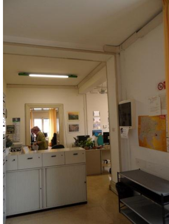
Fig. 7-05: 1P: tubazioni nascoste da rivestimenti metallici.
