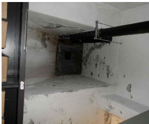
H.1 Espulsione del copriero, colatura
