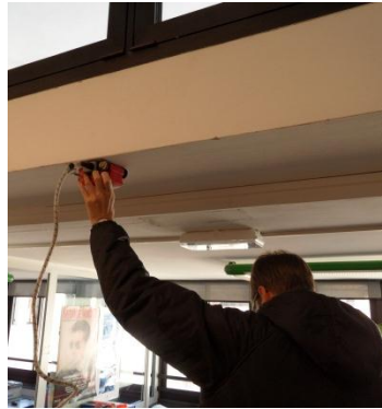
Fig. 5.2.1-02: Esecuzione prova magnetometrica, terzo piano.
