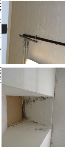
M.1 Espulsione del copriero. M.2 Distacco
