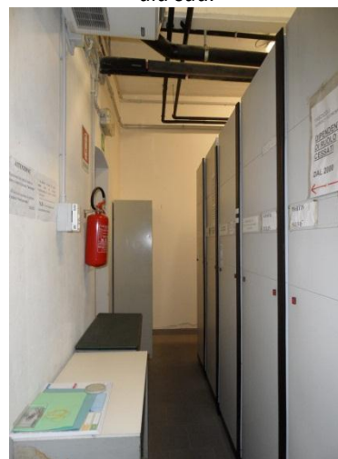
Fig. 3.2-09: Interrato: archivio, ala nord-est.
