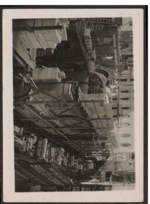
2. Foto storica scattata dall'incrocio tra via VIII Febbraio e via del Municipio. Si notano i pilastri in pietra in primo piano e la muratura in laterizio sul retro.
