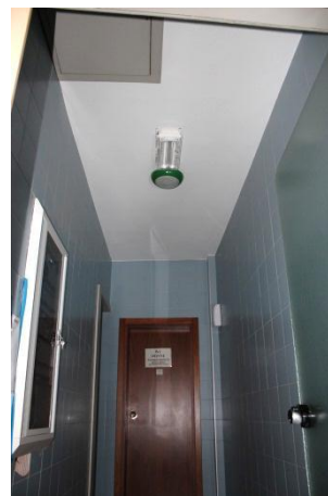
Fig. 7-10: 3P: nicchia ricavata nella muratura per il quadro elettrico.
