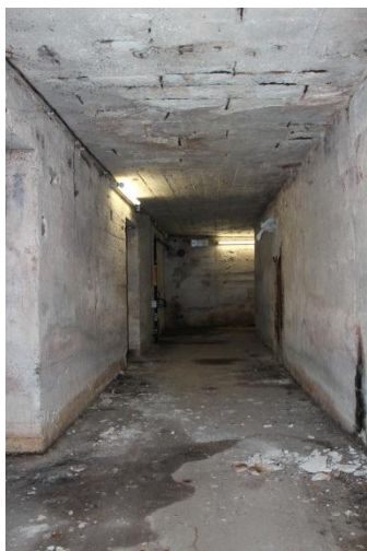
Fig. 3.2-04: Interrato: ex rifugio antiaereo.
