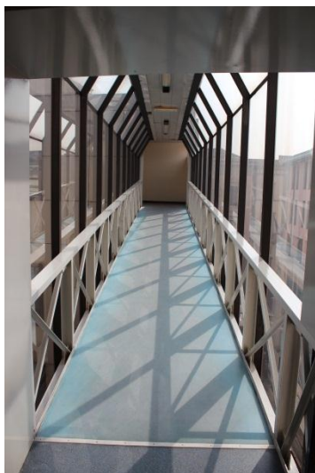
Fig. 3.2-20: 3P: passerella ala sud.
