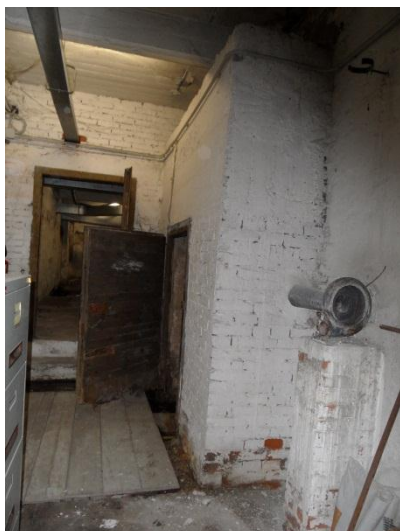
Fig. 6.2.2-19: Interrato: muratura in mattoni.
