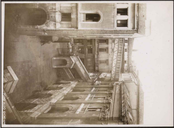
Foto storiche in cui si nota l'assenza del rivestimento di facciata e la presenza, nell'immagine a sinistra, dei muri di spina interrotti. Fonte: materiale iconografico conservato nell'Archivio Generale del comune di Padova.
