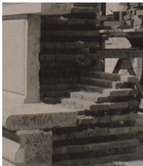
Fig. 6.2.2-22: Foto storica di cantiere in cui è visibile la sezione muraria di una parete perimetrale portante.
