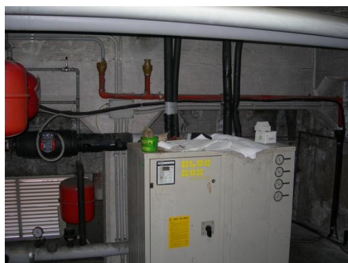
Fig. 3.2-24: Locale tecnico sulla torre campanaria.
