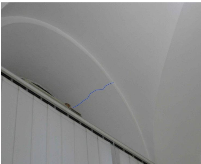
Fig. 6.4.1-10: PT: lesione sulla volta a botte lunettata.
