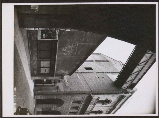
Foto storiche in cui si nota l'assenza del rivestimento di facciata e la presenza, nell'immagine a sinistra, dei muri di spina interrotti. Fonte: materiale iconografico conservato nell'Archivio Generale del comune di Padova.
