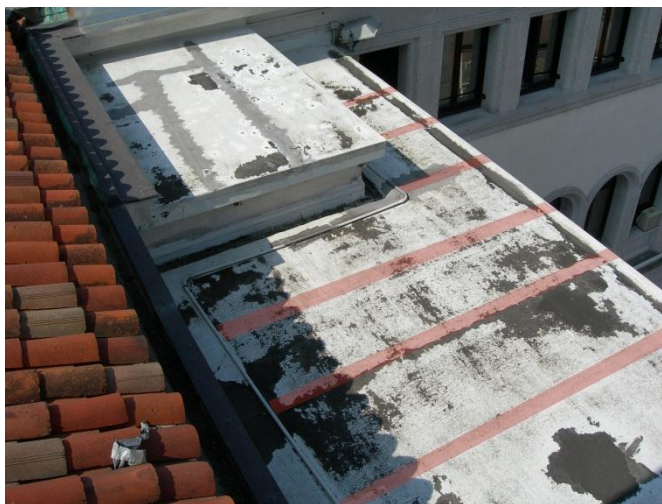
Fig. 6.2.3-07: Copertura piana delle terrazze in cui sono state evidenziate in rosso le possibili travi in acciaio.
