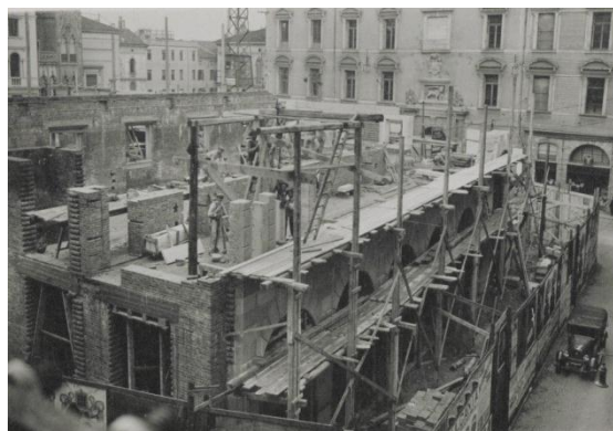
Fig. 6.2.2-16: Foto storica in cui si nota la presenza di mattoni pieni.
