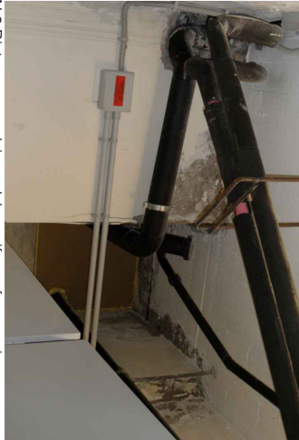
N.3 Distacco, espulsione del copriero, fessurazione
