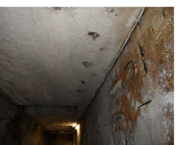
3. Solaio in c.a. nella zona dell'ex rifugio antiaereo.
