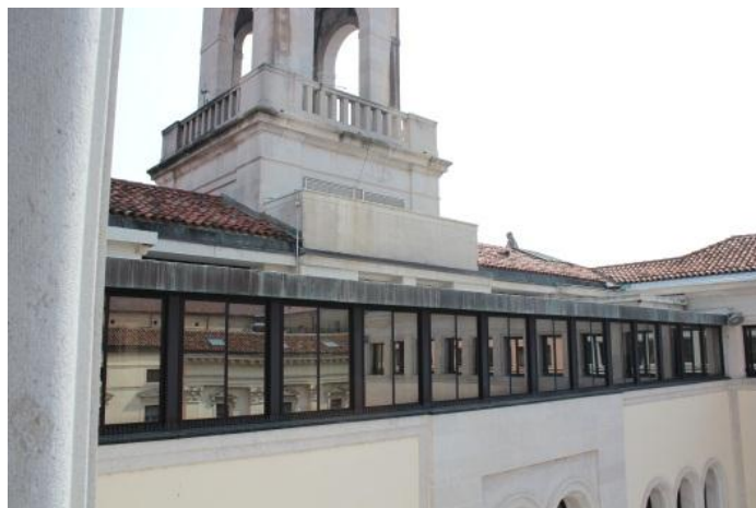
Fig. 2.2-22: Finestrature continue a chiusure delle terrazze, aspetto odierno.
