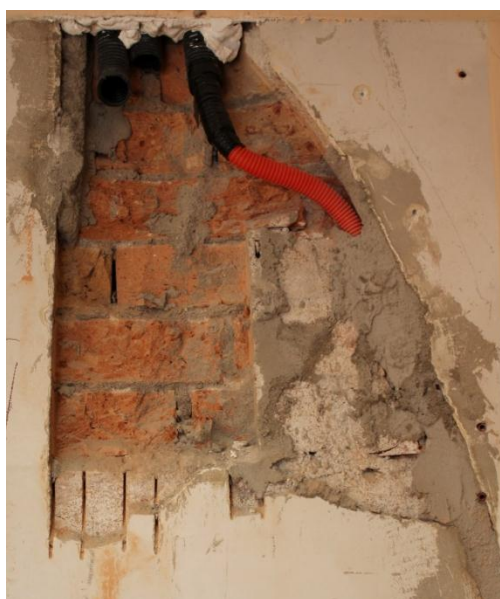
Fig. 6.2.2-21: Porzione di muratura esaminata.
