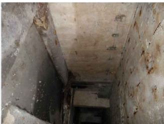
F.4 Alterazione cromatica, espulsione del copriero, lacuna
