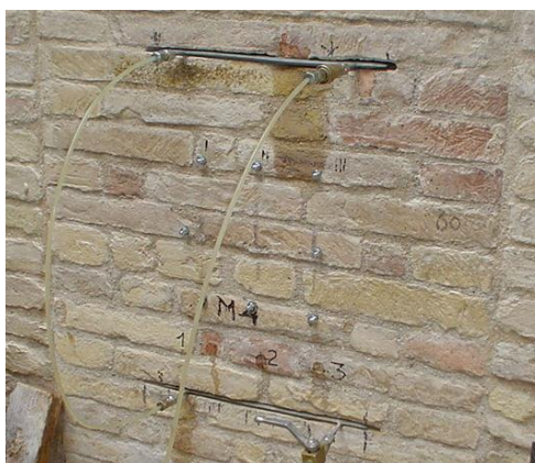
Fig. 5.1.2-04: Esecuzione prova martinetto piatto doppio.
