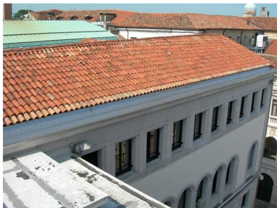
Fig. 3.1-03: Copertura, ala sud.
