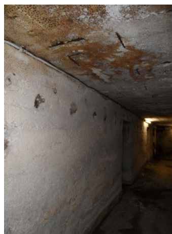
Fig. 6.2.3-02: Interrato, ex rifugio antiaereo: soffitto in c.a..
