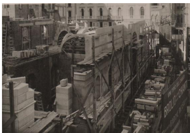
Fig. 6.2.2-18: Foto storica in cui si nota la presenza di elementi in pietra.
