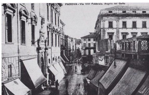
Fig. 2.1-13: Via VIII Febbraio e Hotel Storione sulla destra agli inizi del Novecento.
