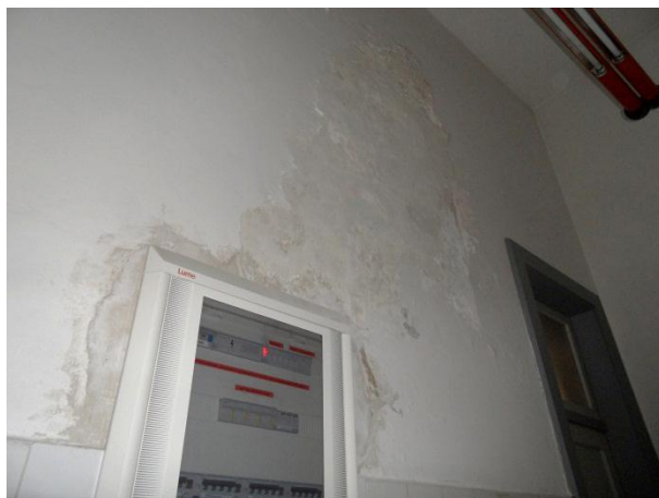
Fig. 7-09: 2P: nicchia ricavata nella muratura per il quadro elettrico.
