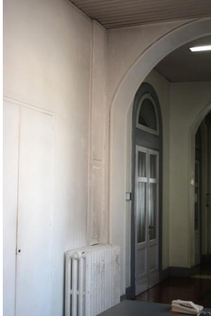
Fig. 7-04: 2P: termosifone e tubazioni nascoste da un rivestimento metallico intonacato.
