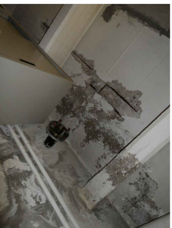
1. Solaio e travi in c.a..
