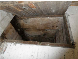
F.1 Alterazione cromatica, distacco, fronte di risalita
