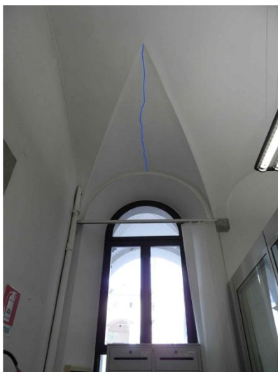
Fig. 6.4.1-09: PT: lesione sulla volta a botte lunettata.
