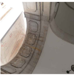
A.4 Alterazione cromatica, colatura
