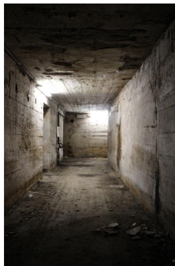
Fig. 6.2.2-20: Interrato: muratura in c.a..
