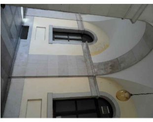
A.2 Alterazione cromatica, distacco
