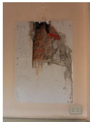
Fig. 6.2.2-17: Foto attuale della zona in cui sono visibili i laterizi pieni.
