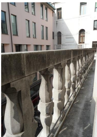
Fig. 3.2-17: 2P: balaustra esterna, ala sud.
