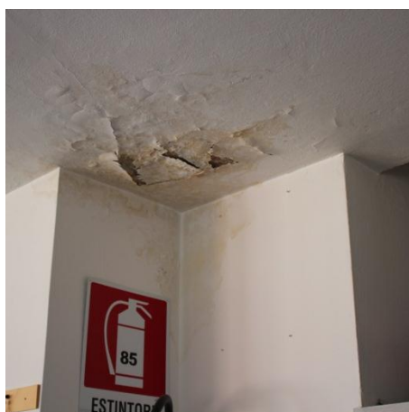
Fig. 6.4.2-18: 3P, ala est: alterazione cromatica, distacco.
