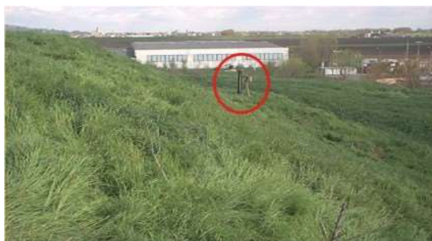
Fig. 6.6.1: Foto di uno dei pozzi per la captazione del biogas posizionato nella scarpata sud della discarica
