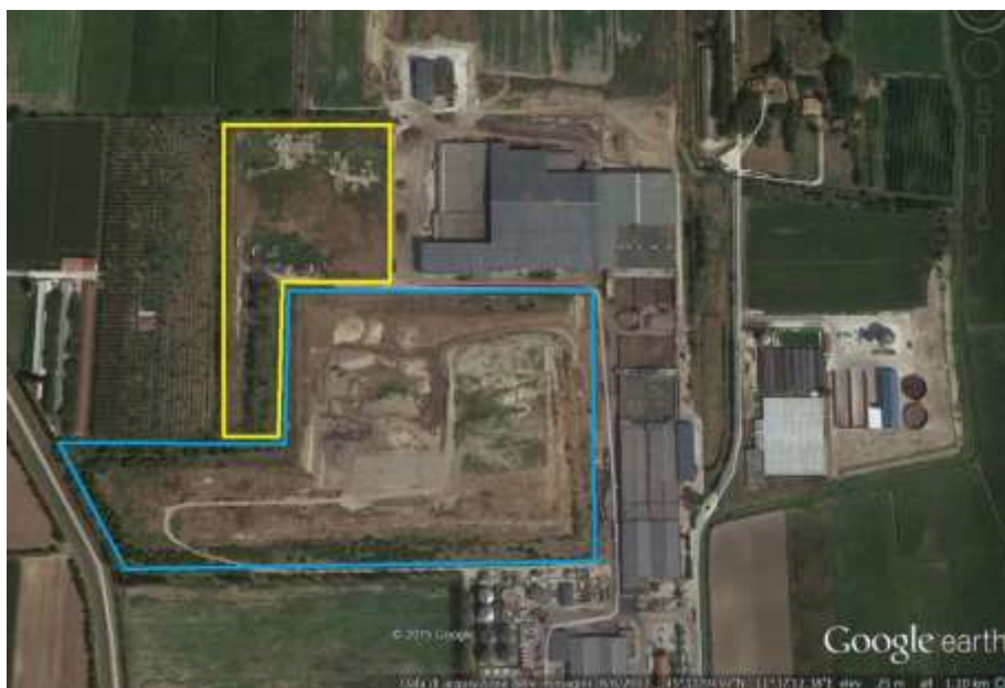
Fig. 6.2.1: Visione aerea della discarica di Este e dell'ampliamento
