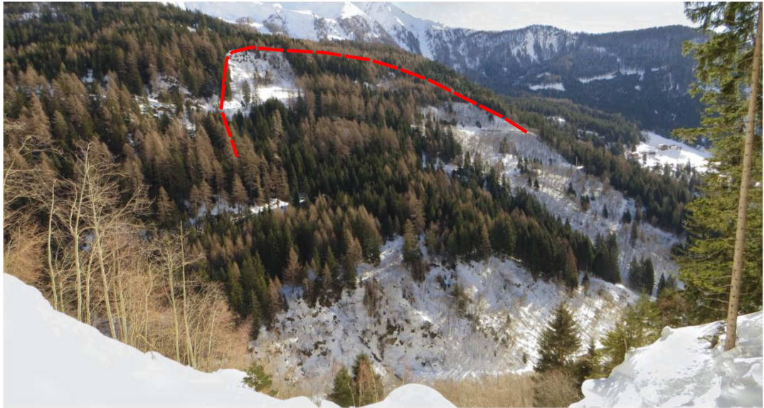
Figura 14 Panoramica della frana "Hahnebaum mure" scattata dal versante in destra idrografica del torrente Passirio
