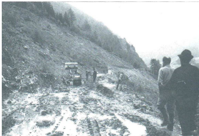
Figura 15 Particolare dei danni subiti dalla viabilità SS44bis in occasione dell'evento del 1962
