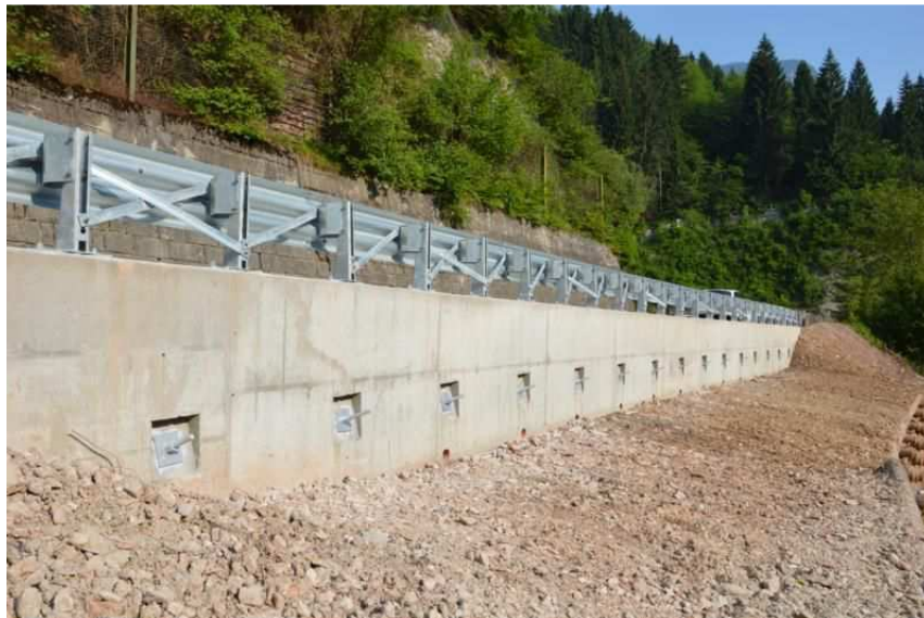
Figura 51 Particolare di un'opera di sostegno con ancoraggio nel substrato
