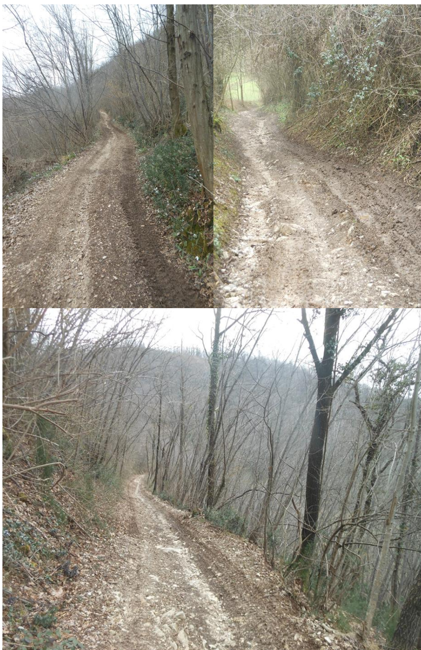
Figura 26. Pista forestale permanente. Nelle immagini in alto particolari del fondo stradale. La tipologia e lo stato del fondo sono molto variabili in funzione anche delle condizioni metereologiche. Nell'immagine in basso la sezione della strada presenta un evidente processo erosivo dovuto al deflusso superficiale dell'acqua. Monte Solone, Colli Euganei.
