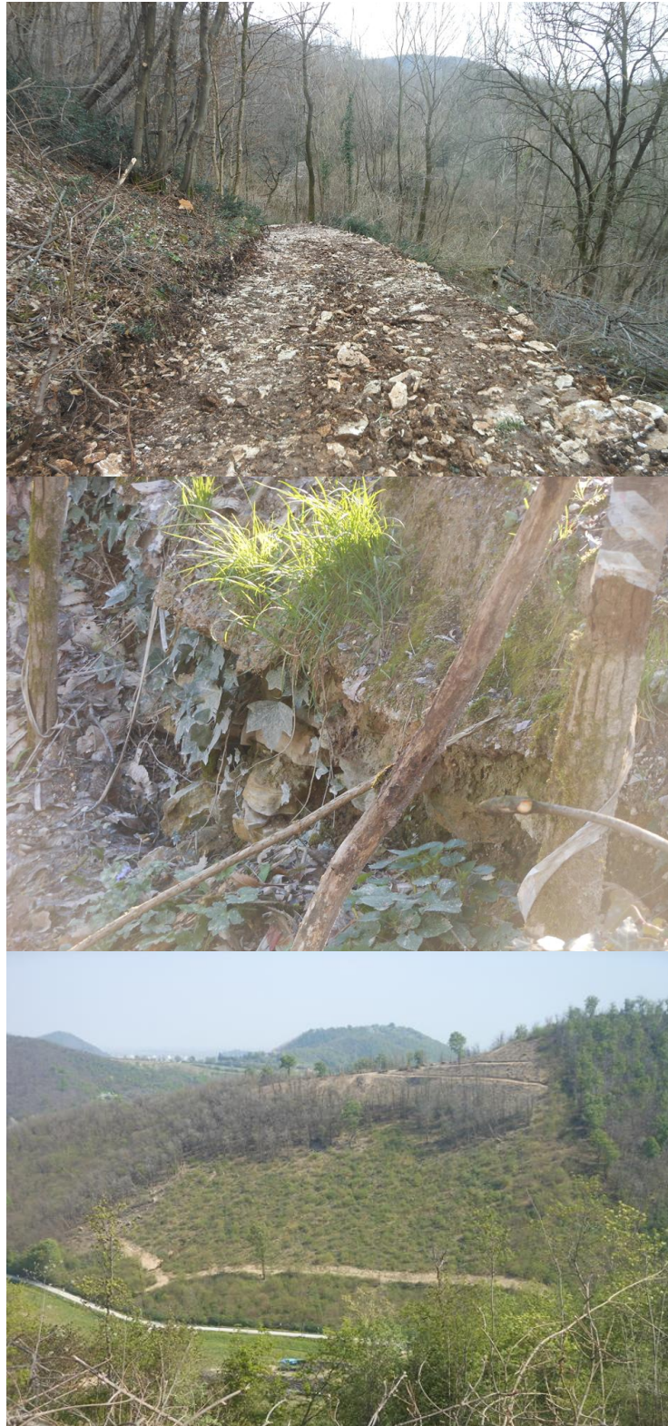
Figura 32. Dall'alto in basso: particolare della tipologia di fondo di una pista forestale permanente, particolare di una scogliera in pietra, attività di esbosco nella zona del Monte Solone.
