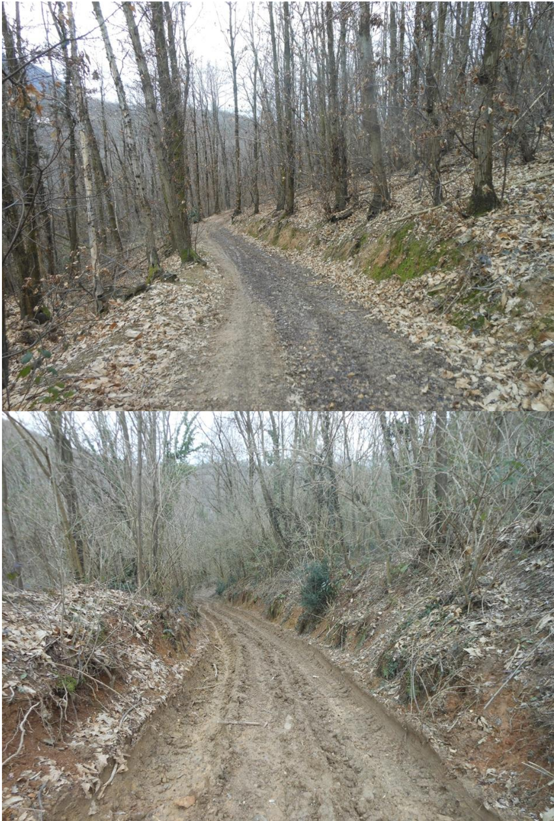
Figura 24. Pista forestale permanente. Dall'alto in basso: il tratto iniziale e il tratto finale della pista secondo la direzione migliore di percorramento. Lo stato del fondo è molto variabile a causa degli eventi metereologici e della tipologia di terreno. Monte Solone, Colli Euganei.
