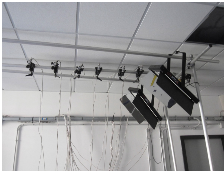
Figura 3.6: L'impalcatura di sostegno delle videocamere e degli illuminatori.
