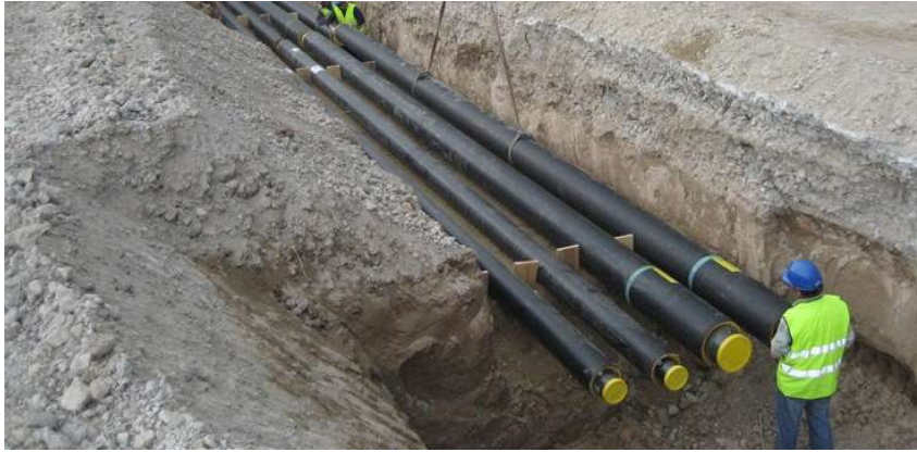
Figura 45 Posa delle tubazioni
