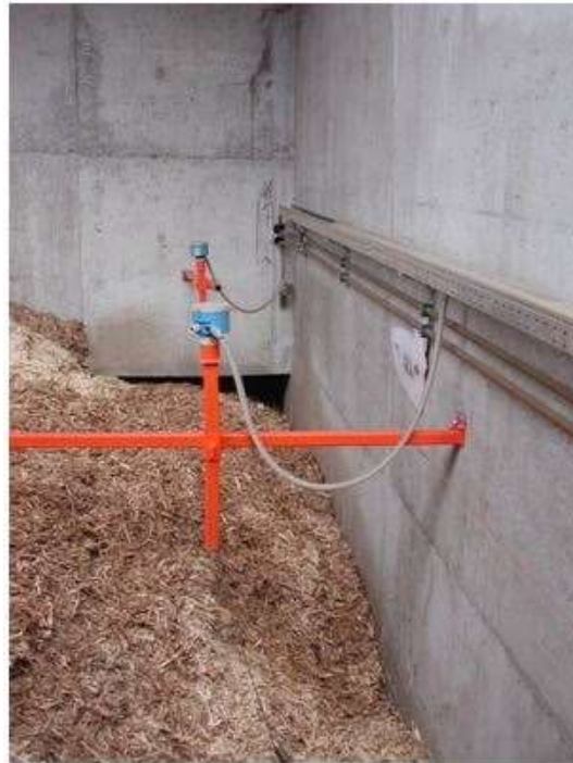
Figura 48 Sistema di sensori ottici di rilevazione del livello di cippato
