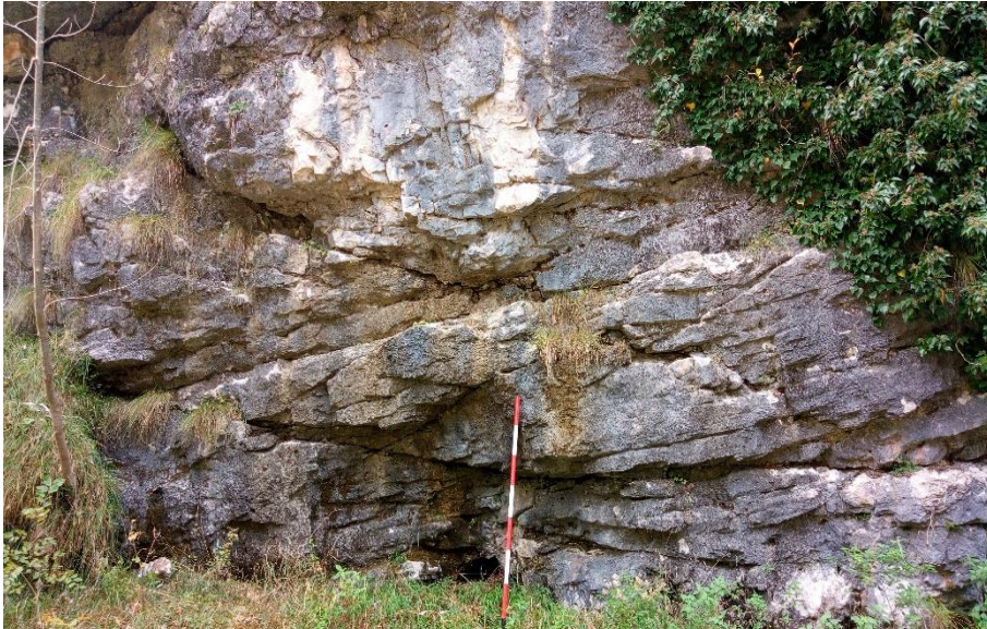
Allegato 9.1: affioramento di Dolomia Principale in Valle del Mis sul quale è stata eseguita la stazione geomeccanica. GSI stimato in campagna 65+-5
