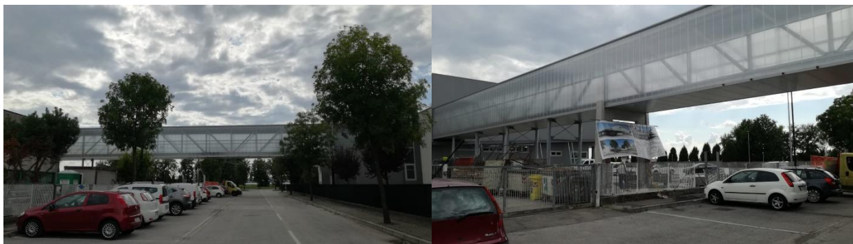
FIG. 3.1: ponte aereo che collega il nuovo magazzino alla sede
