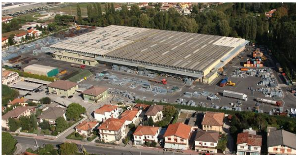
Fig. 1.4: stabilimento produttivo di Fiesso d'Artico
