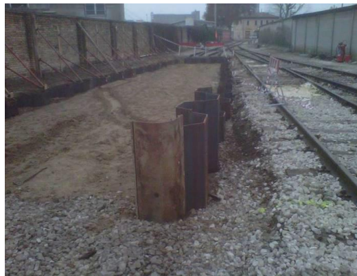
Fig. 4.3 - Infissione delle palancole
