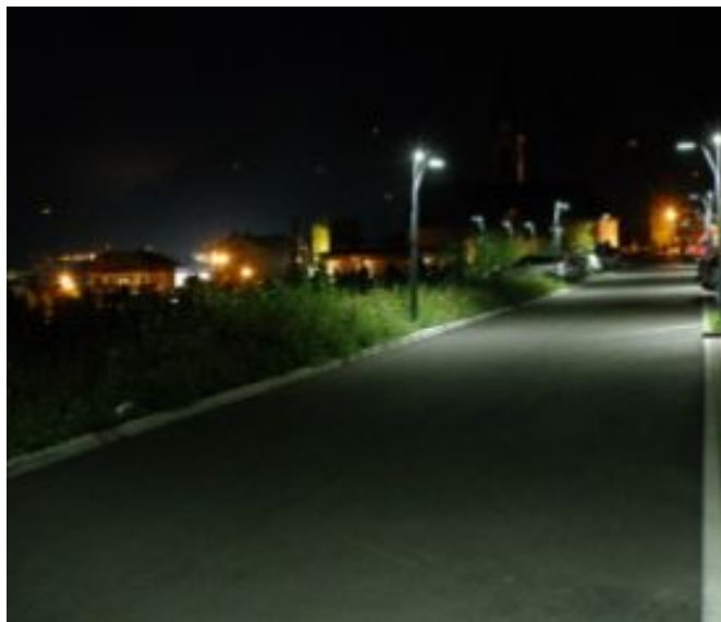
Figura 5.4: In figura sono riportati degli esempi di lampioni con illuminazione a LED [19].
