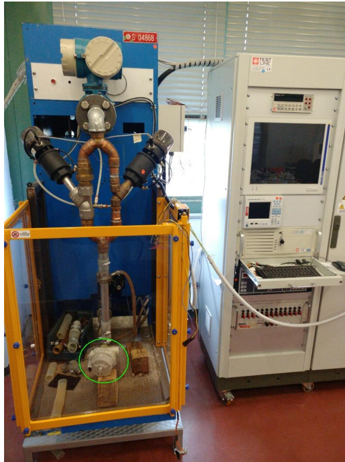
Fig. 3.2-1 Banco per test idraulico
