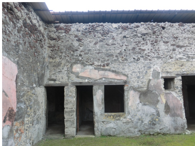
Figura 2.25 – apertura vicino agli spigoli e ridotto spessore dei maschi murari
