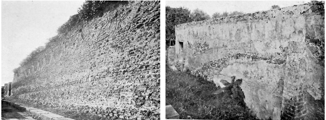
Figura 1.10 – Esempio di archi rovesci (a sinistra) e di pilastri di robustamento (a destra). [A.Maiuri, l'ultima fase edilizia di Pompei.]
