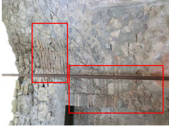
36 Ricostruzione in laterizio
