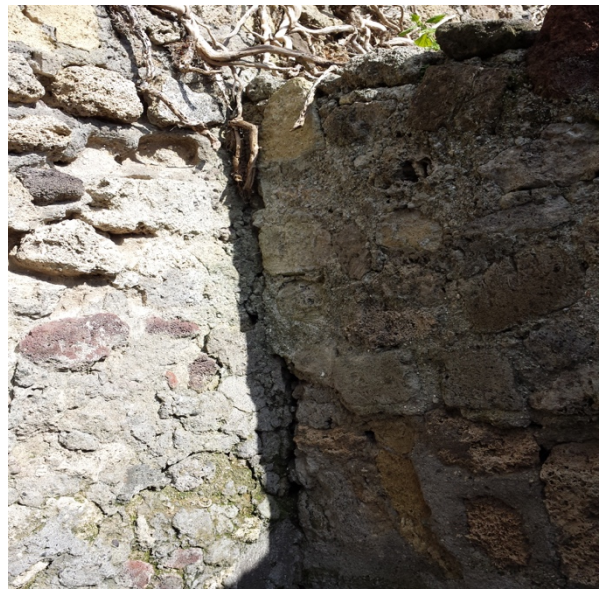
Figura 2.22 - esempio di assenza di ammorsamento
