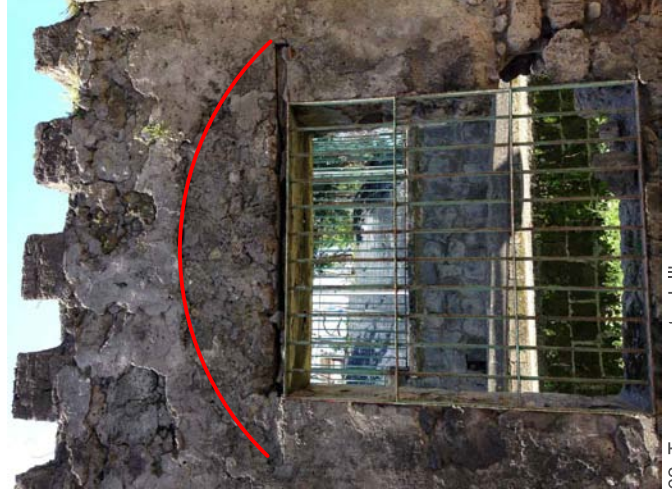
62 Tamponamento dell'arco
