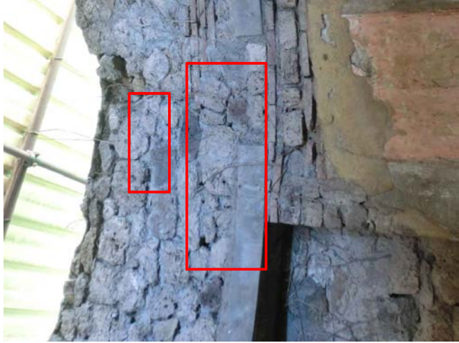
38 Ricostruzione in laterizio
