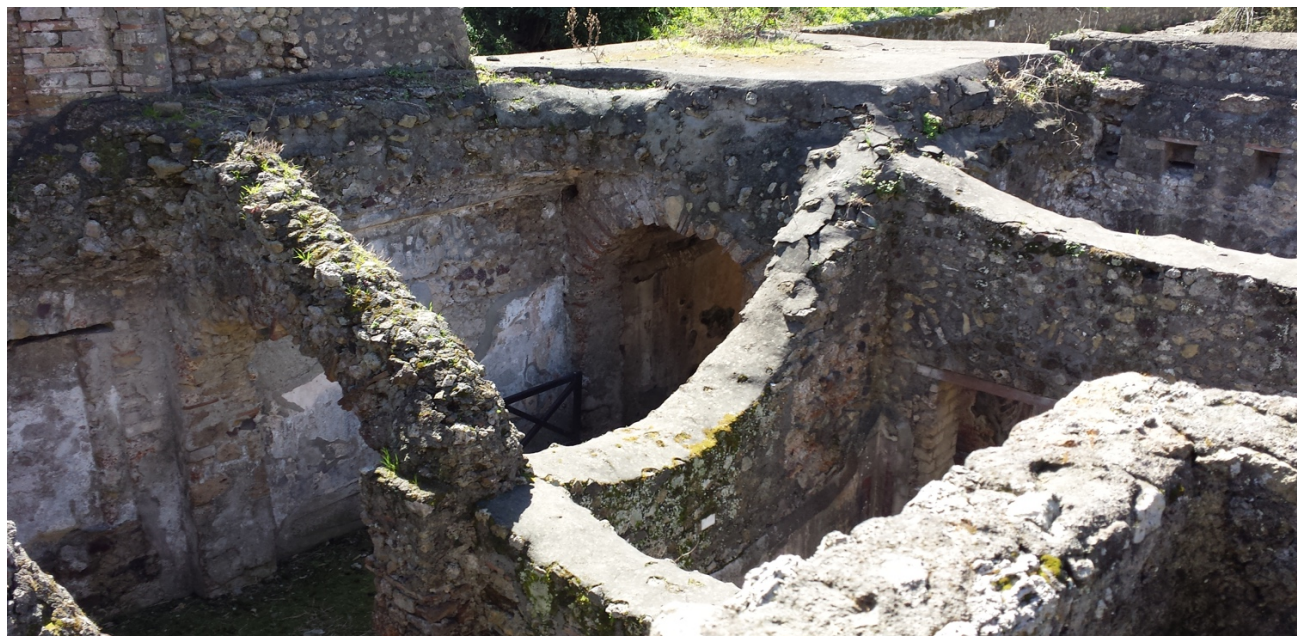
Figura 2.27 – irregolarità in altezza e assenza di orizzontamenti
