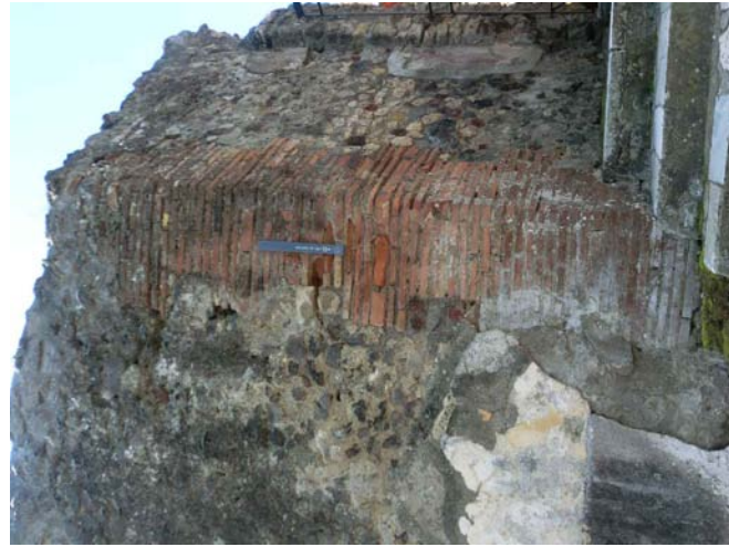
1 Rifacimenti in mattoni
