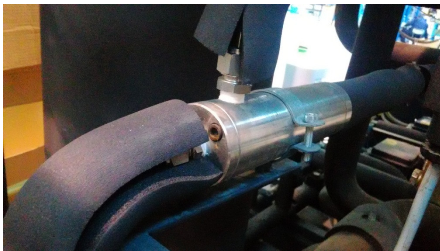
Figura 3.22: Eiettore installato nell'impianto
