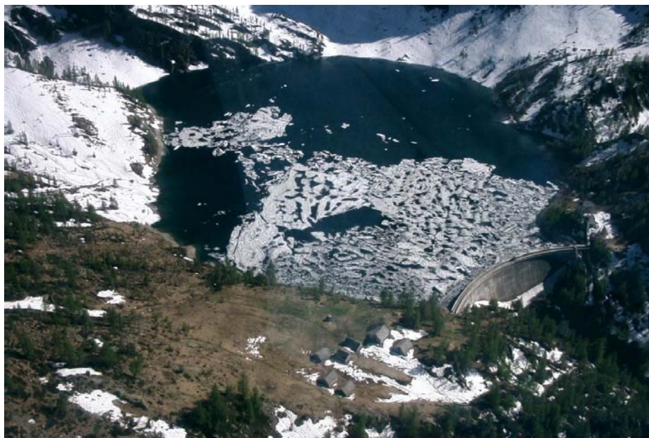
Figura 1-5 Veduta aerea del serbatoio di Larecchio in tarda primavera
