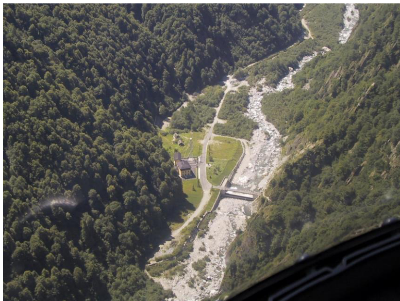
Figura 1-9 Veduta aerea del sistema centrale Ceretti (in caverna), presa Isorno e sottostazione; nel mezzo, il torrente Isorno
