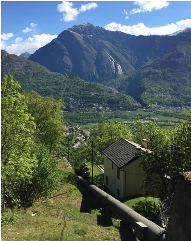
Figura 1-12 Condotta forzata che dalla vasca di carico Melezzo scende alla centrale di Pontetto
