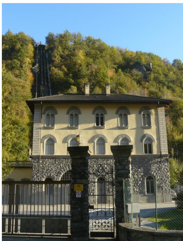
Figura 1-13 Centrale di Pontetto; dietro le due condotte forzate delle due aste
