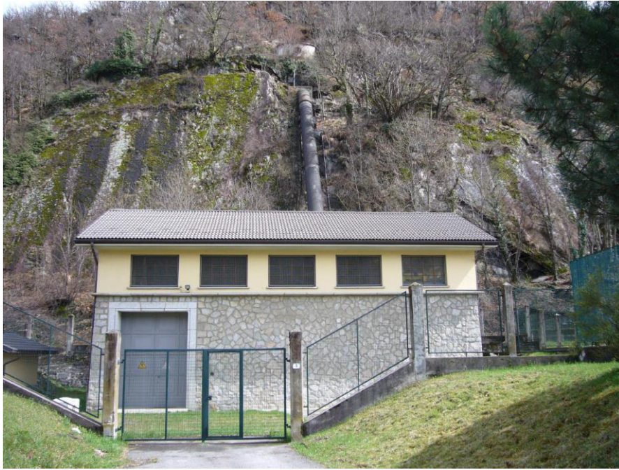
Figura 1-15 Centrale di Montecrestese con condotta forzata visibile
