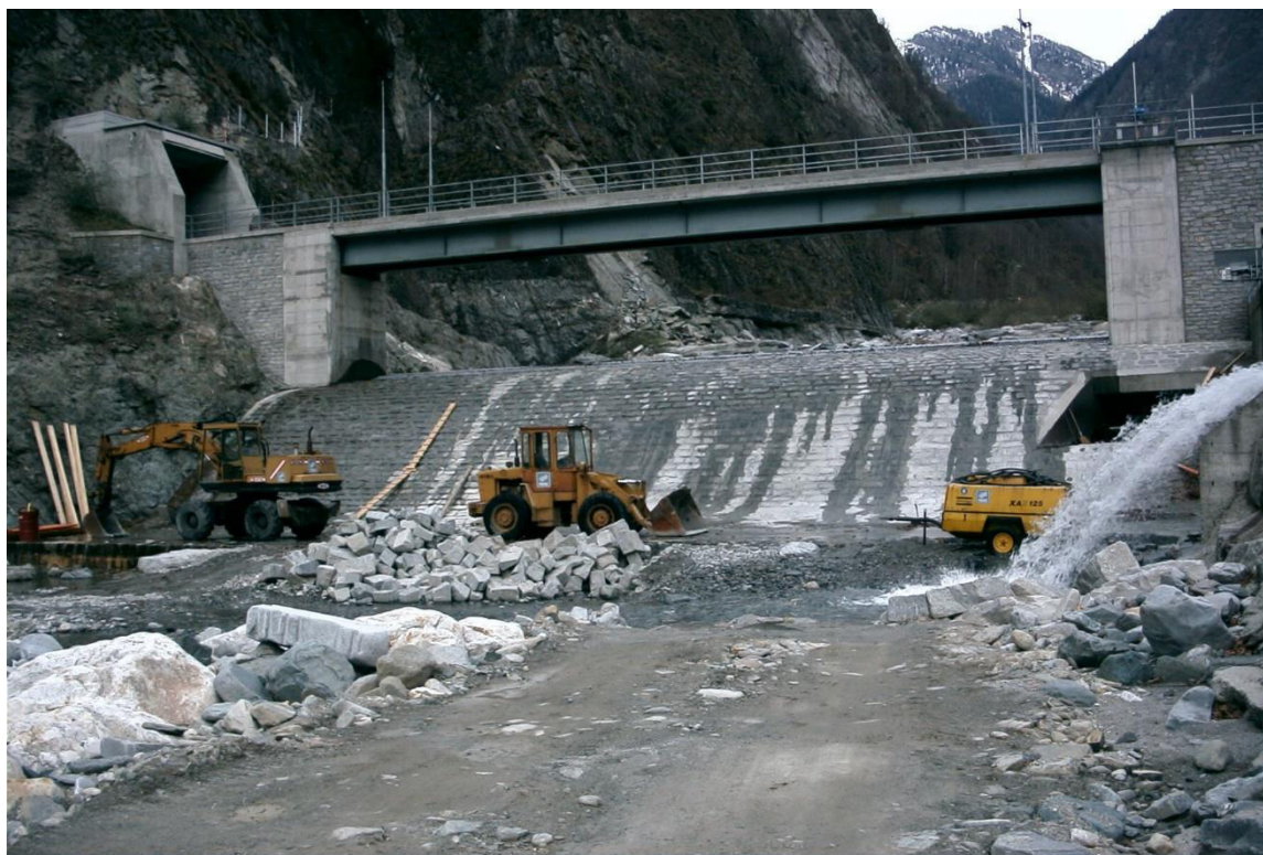
Figura 1-10 Briglia della presa Isorno in costruzione; in alto a sinistra l'entrata alla centrale Ceretti
