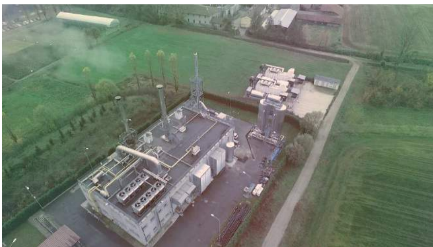
Figura 4.3. 4 Centrale di teleriscaldamento Lodi [83]
