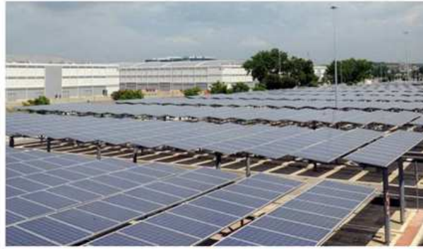
Figura 3.3. 10 Impianto Sporting Lodi [53]
