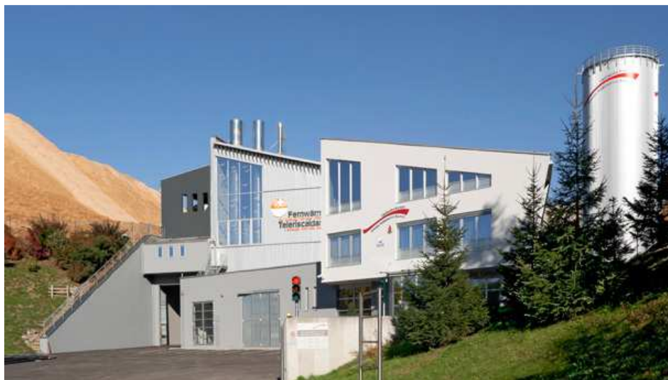
Figura 4.3. 3 Centrale termica di biomassa di Lunes [81]
