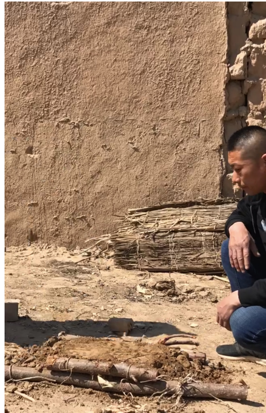
Figura 3.26. Secondo layer compattato
