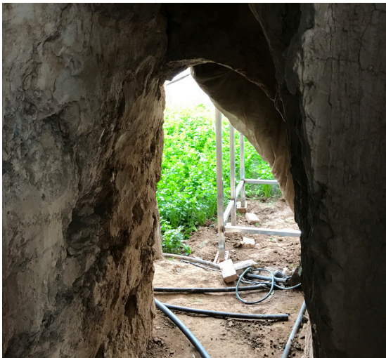
Figura 3.20. Ingresso alla serra attraverso un'apertura nel muro in terra
