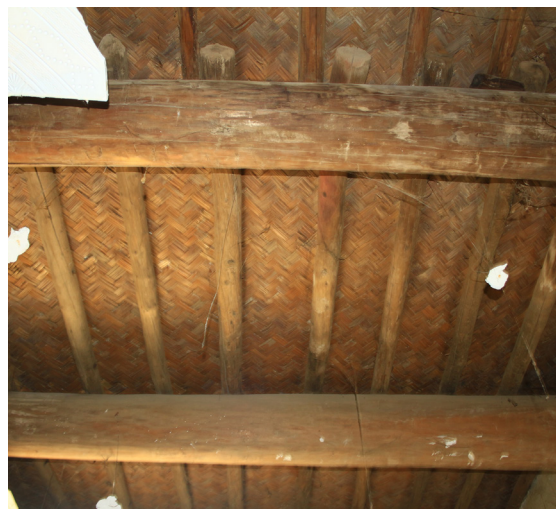
Figura 3.17. Soffitto in legno tradizionale
