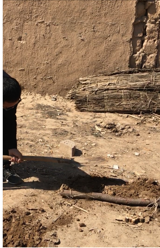
Figura 3.23. Riempimento del primo livello
