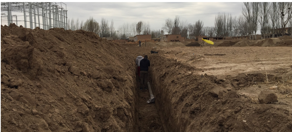
Figura 4.3. Scavo da cui è stato prelevato il campione di terra
