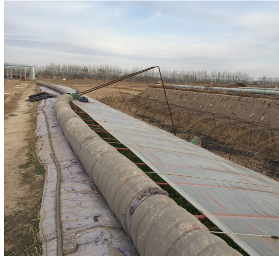
Figura 3.19. Vista del sistema di teli e stuoia per coprire il lato sud. Foto scattata dalla sommità del muro in terra.
