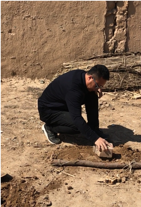
Figura 3.25. Compattazione della terra
