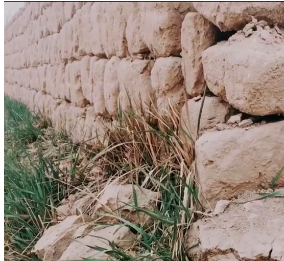
Figura 3.8. Muro perimetrale in adobe
