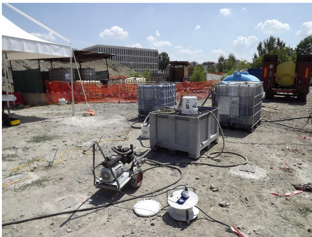
Fig. 22 - Impianto sul posto per la preparazione della miscela.
