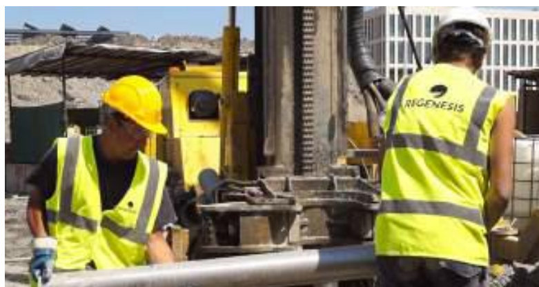
Fig. 21 - Perforazione nel sito dei pozzetti che serviranno per le iniezioni [Regenesi].
