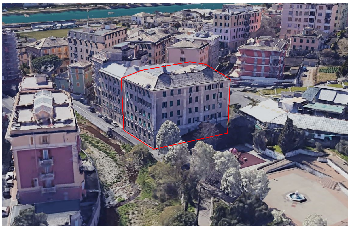
Figura 5.1 – Vista di Google Earth del caso studio
